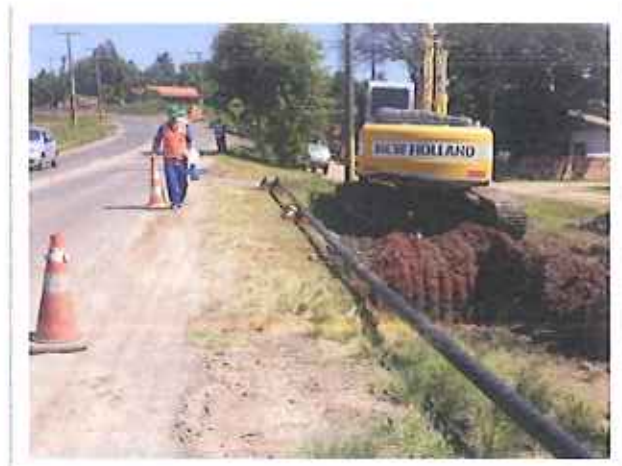
Figura 4: Tubulação a ser instalada na margem da Rodovia Lino Zanolli – ICR 364
