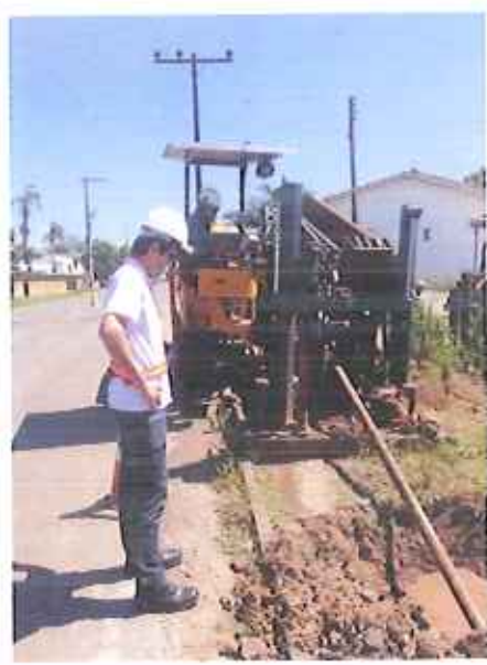
Figura 6: Equipamento Perfuratriz trabalhando.
