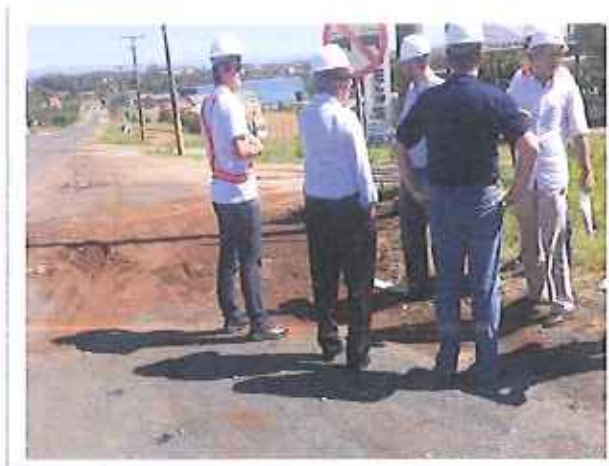
Figura 3: Derivação da tubulação para chegar até a Farben S/A
