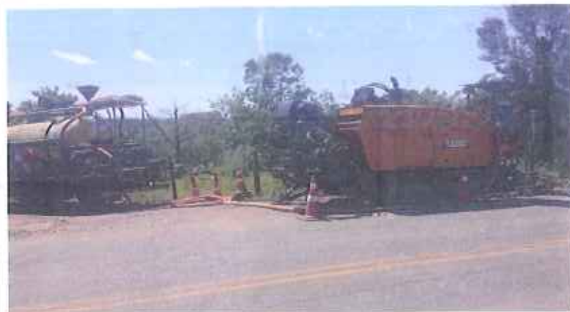
Figura 5: Equipamento Perfuratriz e caminhão tanque de água.
