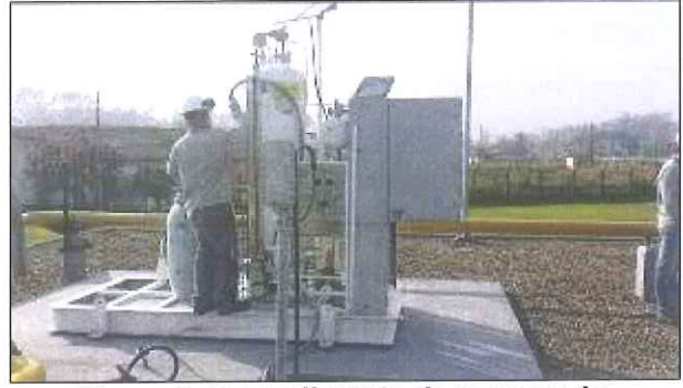
Figura 7: Procedimento de recarga do odorante.
