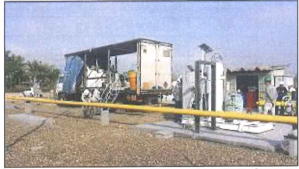
Figura 9: Procedimento de recarga do odorante.
