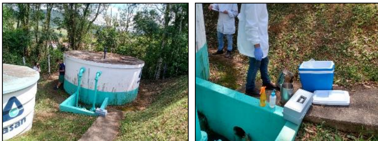
Figura 2: Visão geral da ETA do município de São Martinho e coleta de amostras de água tratada na ETA São Martinho (04/11/2021).
