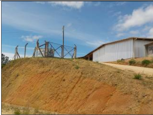
Figura 27: Vista do acesso ao Reservatório Gabiroba, boas condições.
