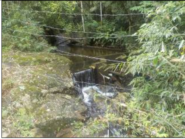
Figura 3: Vista Geral da Captação Rio Cachoeira (superficial).
