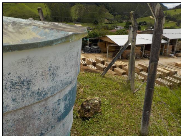
Figura 30: Vista de parte do reservatório Gabiroba e o cercamento em boas condições.
