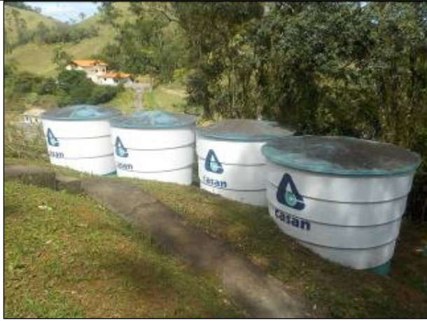
Figura 15: Vista Geral dos Reservatórios R1, R3, R4 e R5, interligados junto a ETA (40m³), com tampas superiores e estruturas laterais em boas condições. Interligados entre eles e com o R2.
