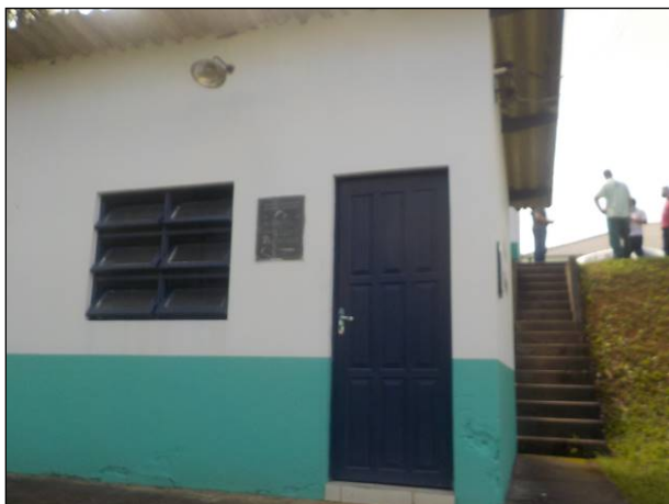
Figura 7: Vista do acesso e da entrada do local onde o tratamento da água bruta é realizado na ETA São Martinho, boas condições.
