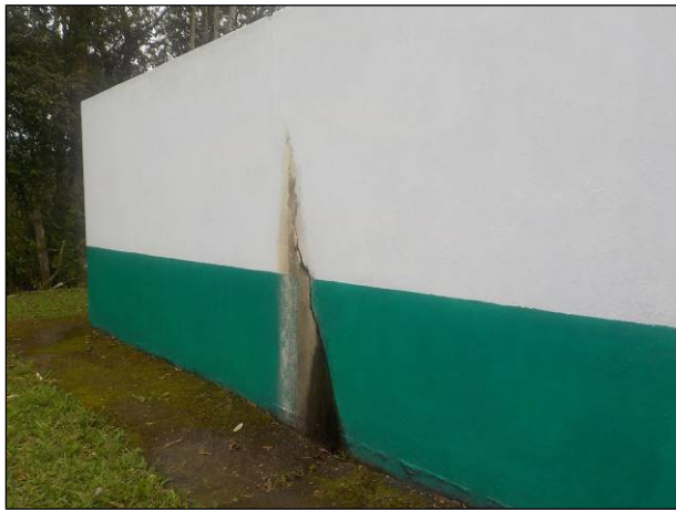
Figura 17: Estrutura disponível no terreno da ETA São Martinho.
