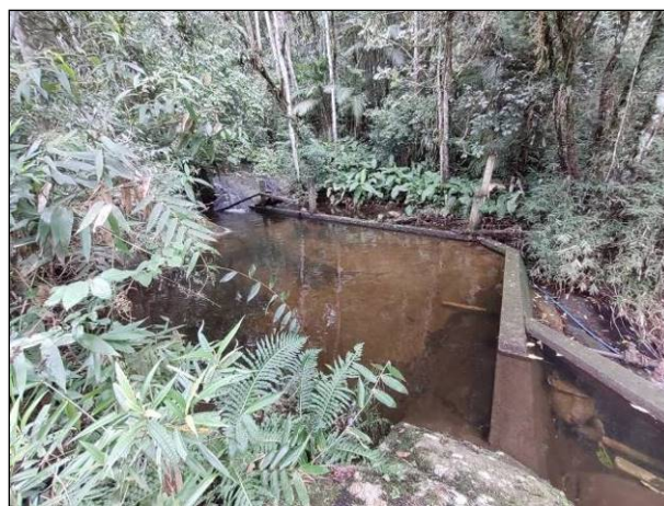
Figura 2: Vista da barragem de concreto e do ponto de Captação (ao dentro e à direita da barragem) disponível, limpeza e equipamentos em condições satisfatórias.
