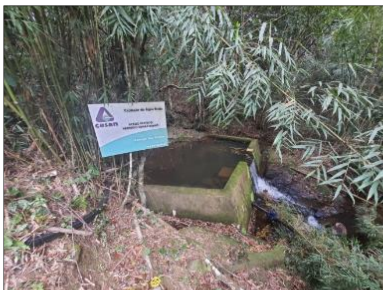
Figura 1: Visão geral do ponto de captação de água bruta no Córrego João Roesner (31/08/2021).
