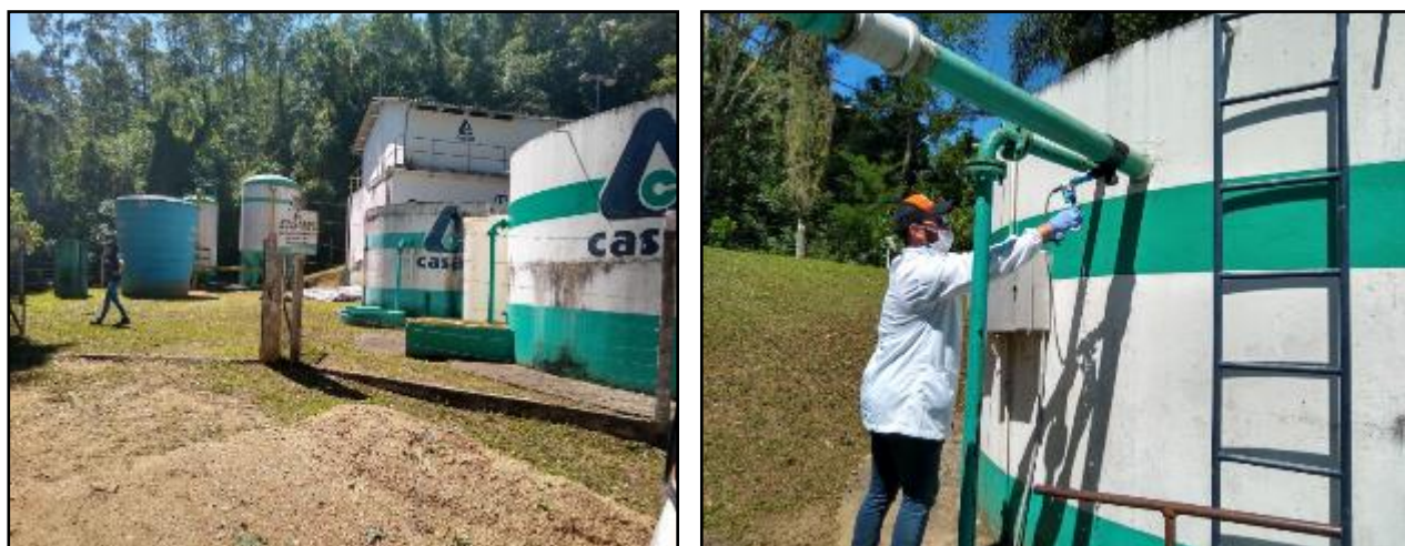
Figura 2: Visão geral da ETA de Rio Fortuna e coleta de amostras de água tratada na saída do tratamento (05/11/2021).
