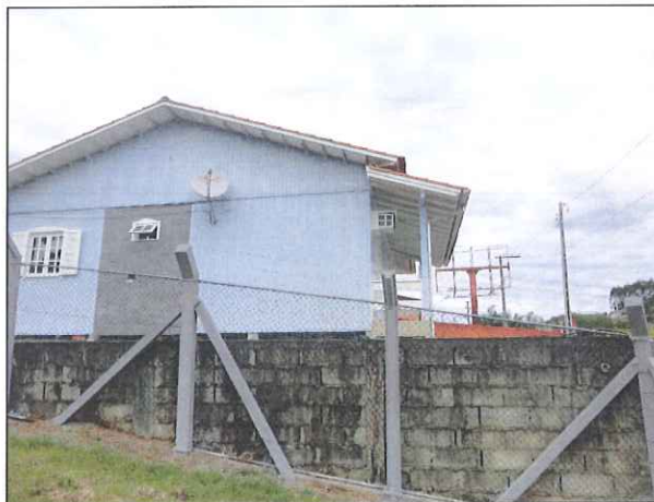
Figura 7: Altura da cerca de proteção
