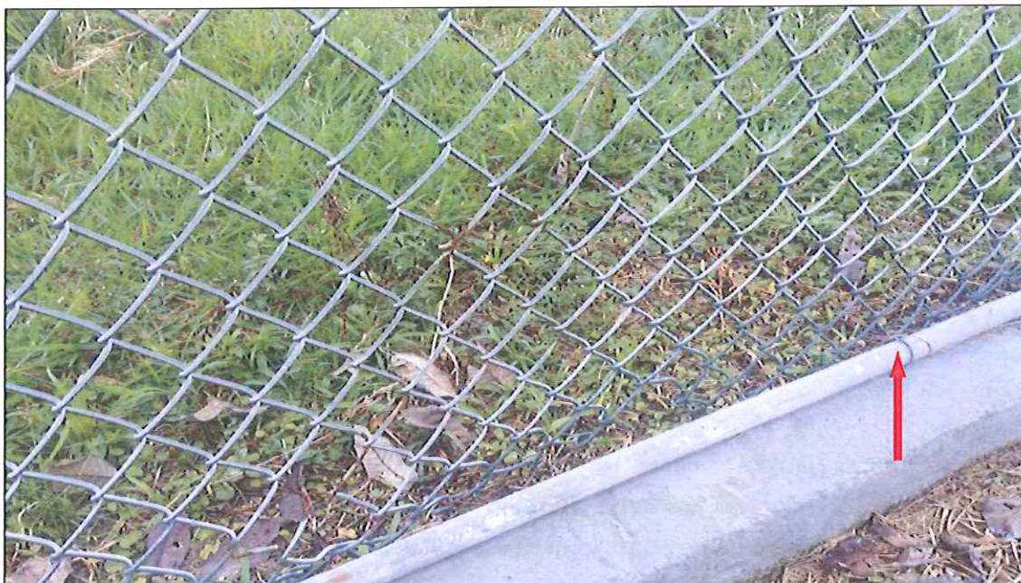
Figura 2: Os pontos de fixação da parte inferior da tela estão muito espaçados.
