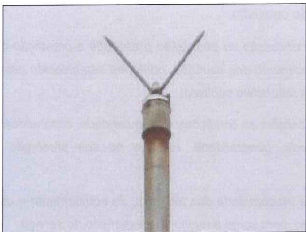
Figura 28: Para-raios sem a haste central
