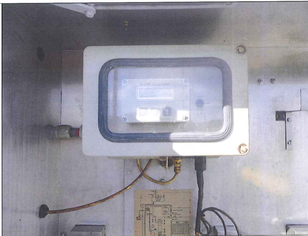
Figura 10: Display do Equipamento de Odoração inoperante.
