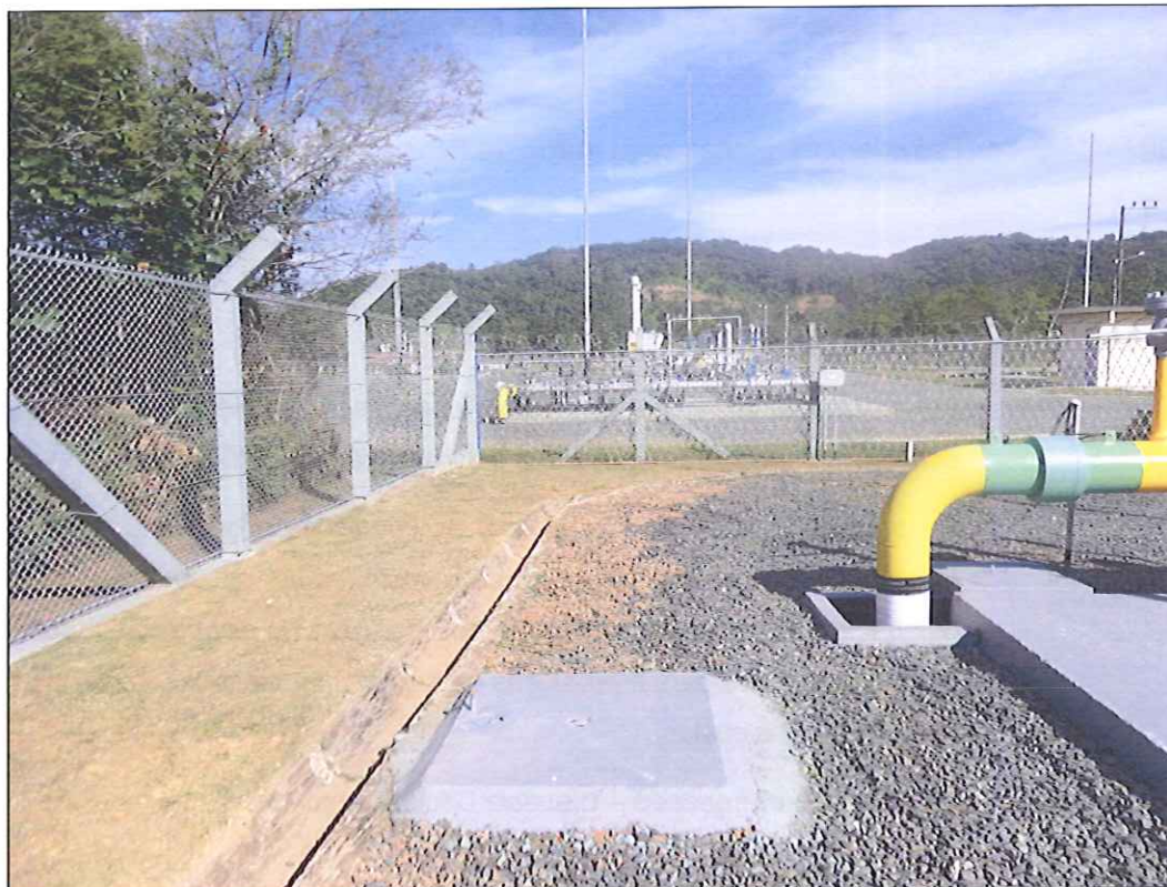
Figura 8: Desinstalação do Chuveiro e Lava Olhos.
