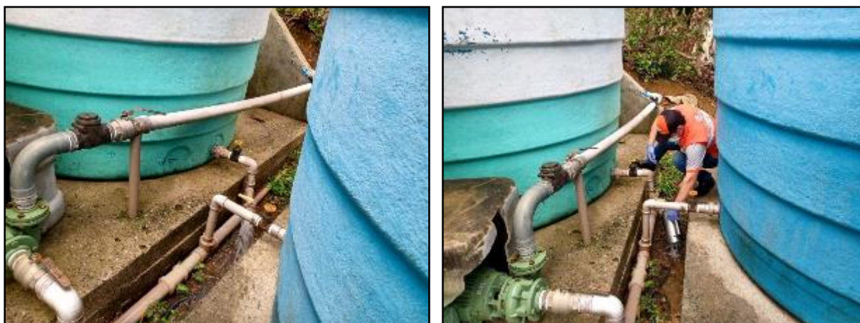
Figura 5: Visão geral e coleta de amostras de água tratada no Reservatório R3 (30/08/2021).
