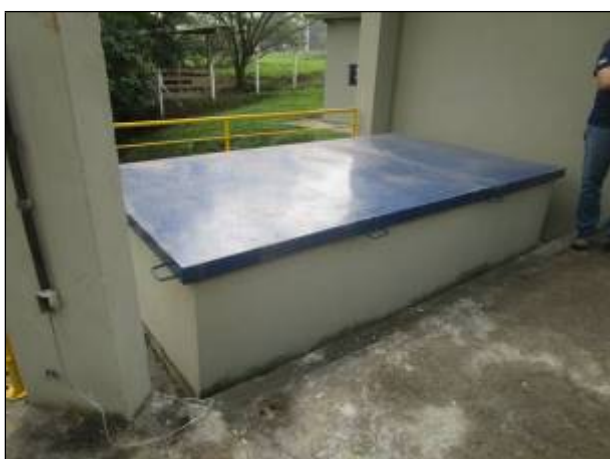
Figura 23: Nova estrutura para retirada e colocação de uma das bombas de recalque de água bruta.
