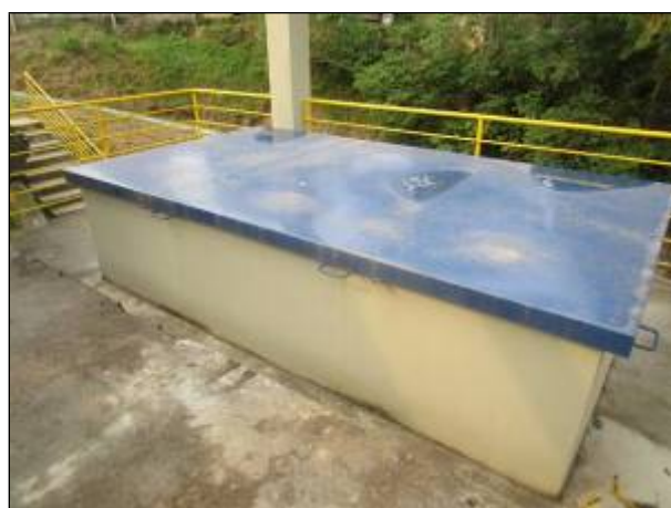
Figura 24: Nova estrutura para retirada e colocação de uma das bombas de recalque de água bruta.
