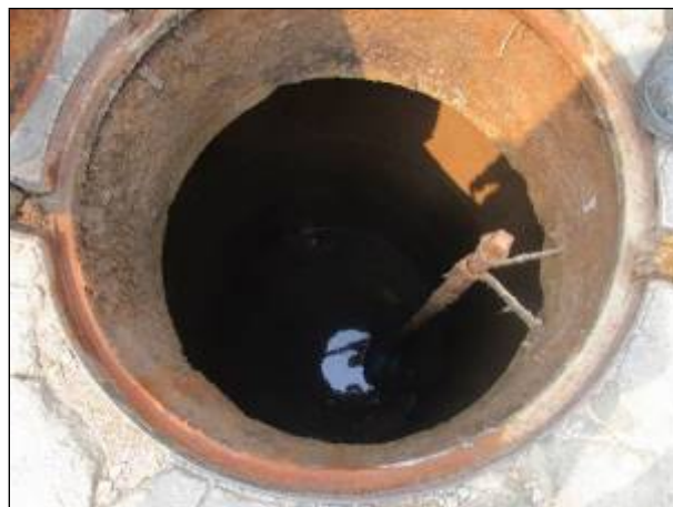
Figura 100: Vista do interior de um dos poços de visita do SES, especificamente da EEE C2, sem inconformidades.
