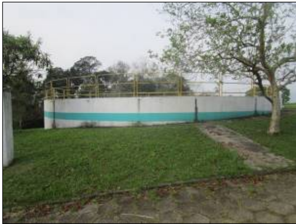
Figura 73: Vista do reservatório R 002, semienterrado e em condições satisfatórias, possui monitoramento remoto.
