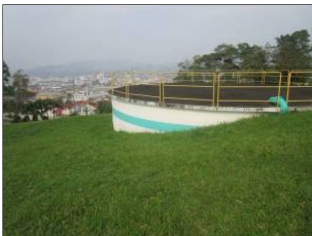
Figura 71: Vista do reservatório R 001, conectado com o R 002.
