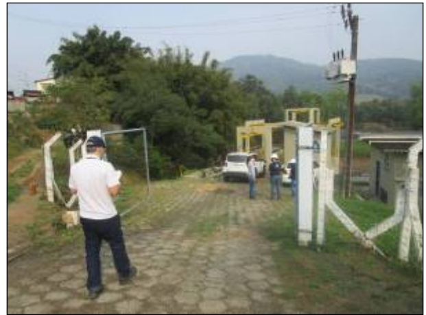
Figura 14: Vista do portão de entrada da Captação de água bruta, portão e cercamento adequados.
