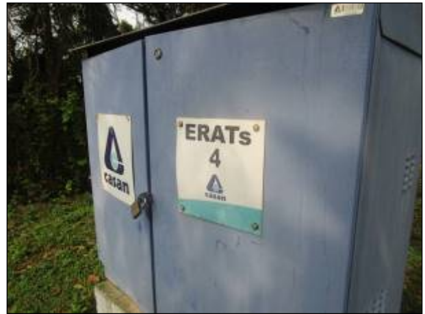
Figura 62: Vista da placa do Booster 04 , localizado no mesmo terreno da ETA. A placa está com a nomenclatura incorreta. Há cadeado e acompanhamento remoto.
