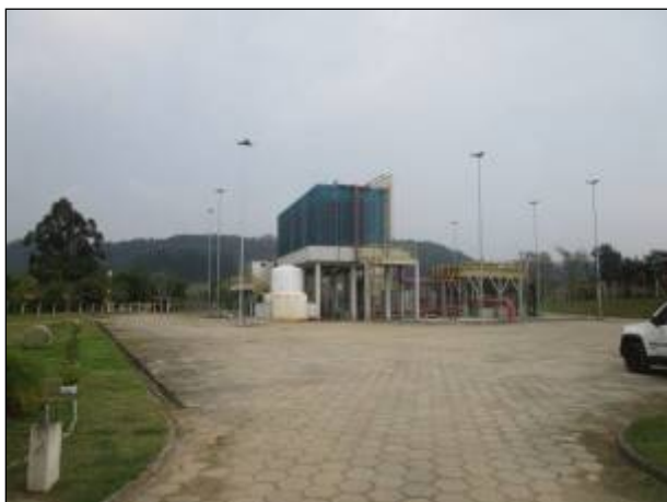
Figura 79: Vista da ETE Braço do Norte, portão de entrada e cercamento da unidade em condições satisfatórias, incluindo a placa de identificação e iluminação.
