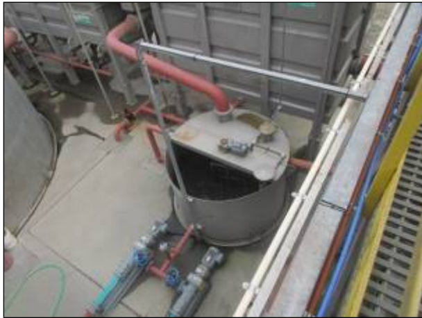
Figura 85: Vista do tanque de lodo flotado, em boas condições.
