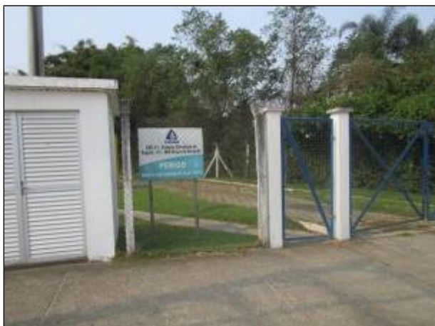
Figura 101: Vista da entrada da EEE C1, com cercamento e portão de acesso em boas condições.
