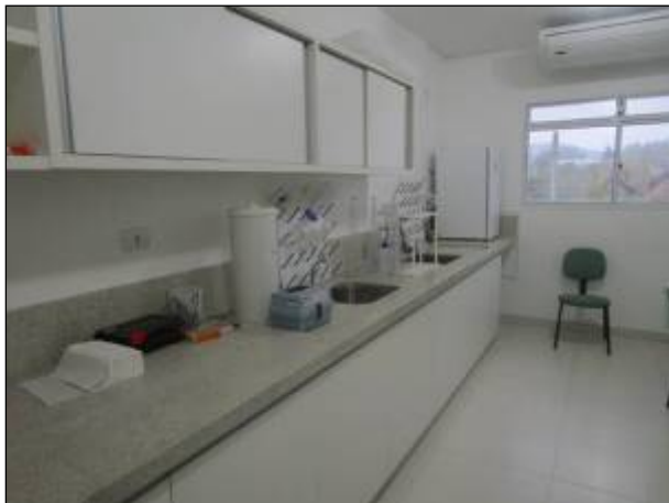
Figura 93: Vista do laboratório local em boas condições, com armários apropriados, mas cadeiras insatisfatórias para os operadores.
