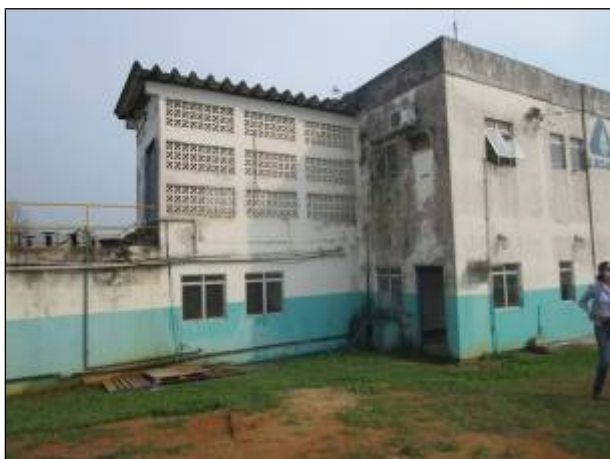
Figura 27: Vista da edificação onde está localizado o tratamento de água local.
