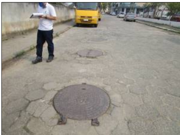
Figura 99: Vista geral das tampas do sistema de inspeção do SES em frente à central de comando da EEE C2.
