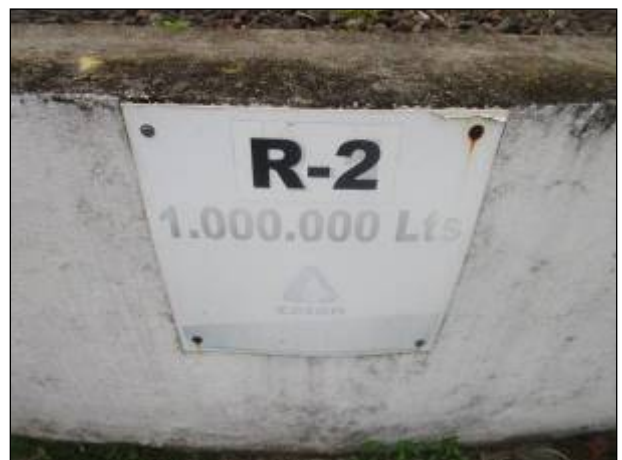
Figura 72: Vista da placa indicando o reservatório R 002 em condições insatisfatórias.
