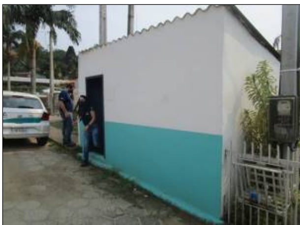
Figura 55: Vista do Booster 02 , sem placa restritiva e informativa do local.
