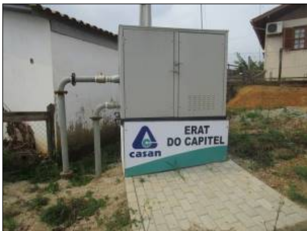
Figura 53: Vista da ERAT do Capitel, placa de identificação e estrutura em boas condições. Há acompanhamento remoto.
