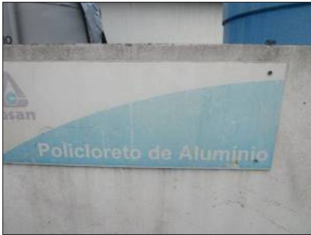
Figura 49: Vista da placa, em condição satisfatória, indicando o produto que ali está armazenado para uso imediato.
