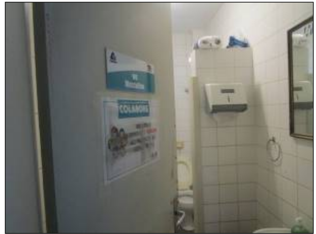
Figura 6: Vista do interior do banheiro masculino disponível para uso.
