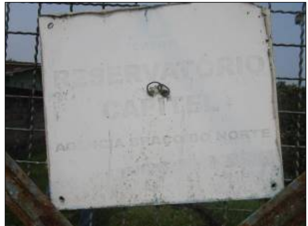
Figura 76: Vista da placa indicativa do reservatório do Capitel, em condições insatisfatórias.
