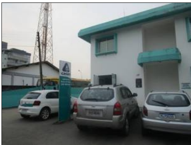
Figura 1: Escritório de Atendimento em Braço do Norte/SC.
