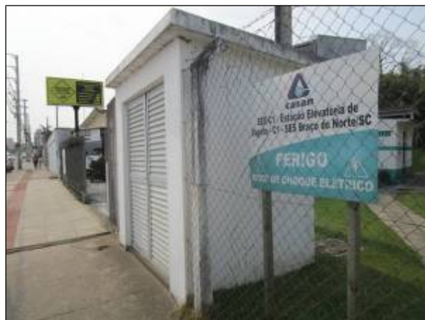
Figura 102: Vista da placa indicativa da EEE C1, esta contendo também o alerta de perigo para energia elétrica.
