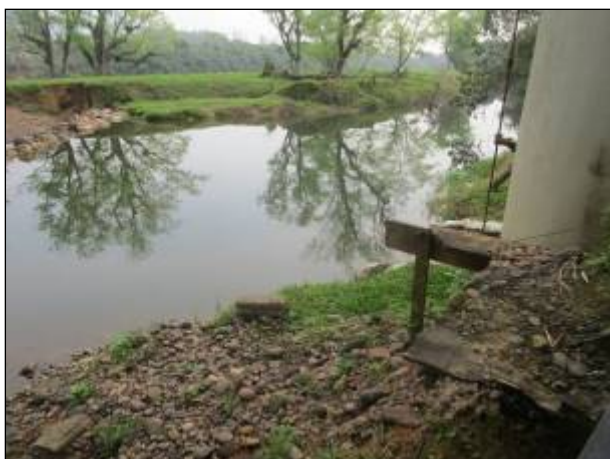
Figura 19: Vista da barragem de Captação de água bruta, revitalizada no ano de 2020 para evitar problemas com enchentes no local. Limpeza (dragagem) anual planejada.
