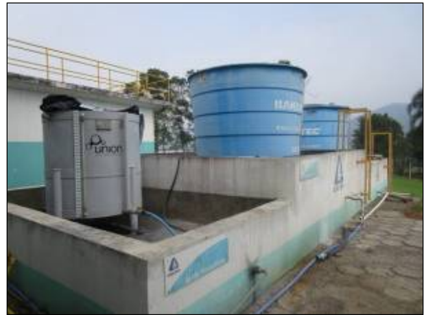
Figura 50: Vista do local em boas condições, tampas e acesso.
