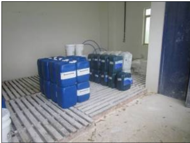
Figura 51: Vista do local de armazenagem dos produtos químicos na ETA Braço do Norte, paletes e ventilação em boas condições.
