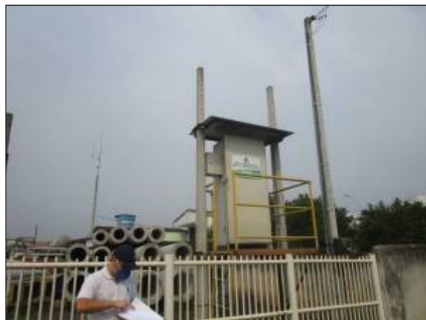
Figura 98: Vista da unidade que fica localizada em patamar elevado devido a área ser suscetível a inundações em alguns períodos.
