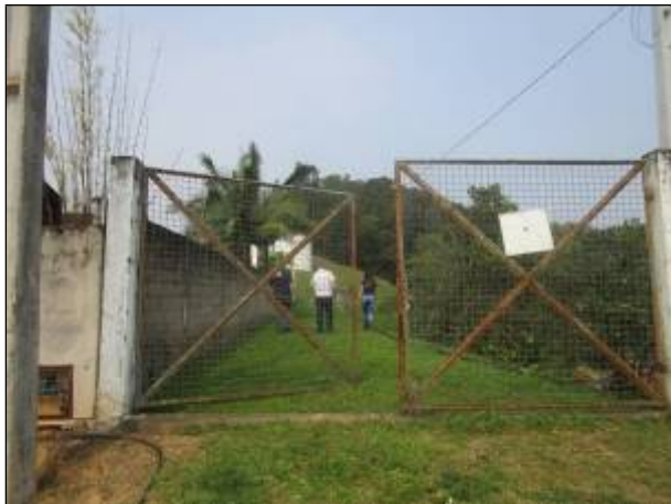
Figura 75: Vista do portão de entrada do reservatório do Capitel (R 003) em condições satisfatórias.
