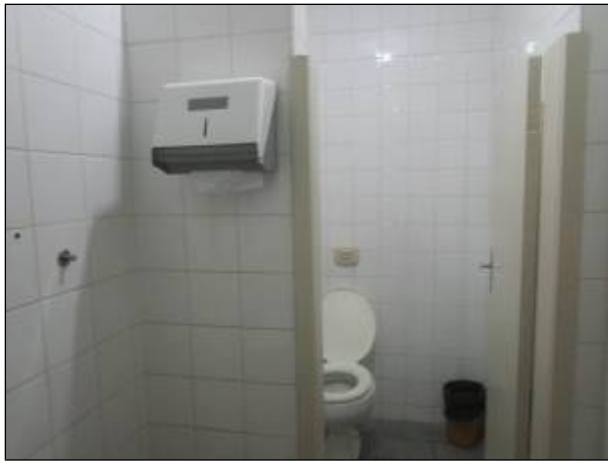
Figura 5: Vista do interior do banheiro feminino disponível para uso.
