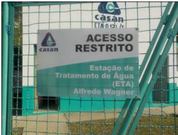
Figura 15: Placa indicativa da unidade no portão de acesso de pedestres da ETA Caeté.
