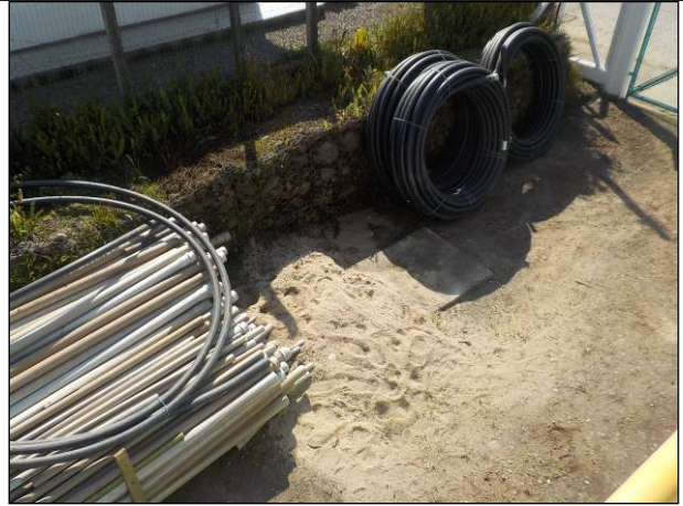
Figura 24: Acúmulo de objetos não necessários à ETA Caeté, portanto armazenados inadequadamente no local. Neste deve ser disposto um leito de secagem, segundo informações coletadas em campo.
