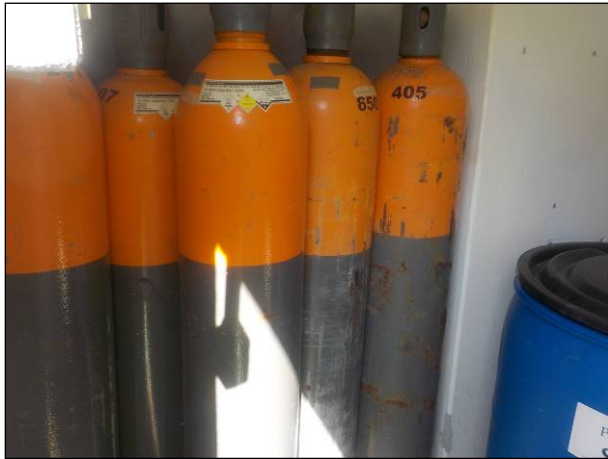
Figura 25: Cilindro de cloro em gás em desuso, equipamentos devem ser retirados do local.
