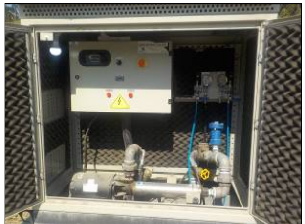
Figura 44: Parte interna do Booster 4 , condições satisfatórias.
