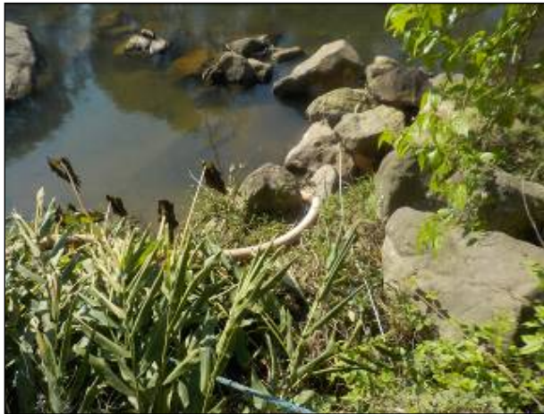
Figura 13: Vista da parte estrutural da captação, sem isolamento e sem macromedidor para a entrada da ETA.
