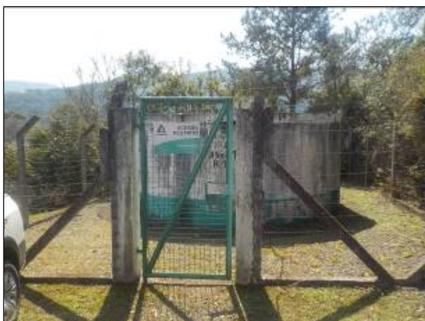
Figura 33: Vista do cercamento do Reservatório R3.
