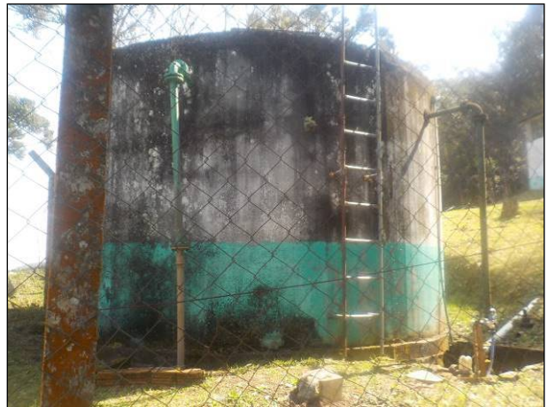
Figura 40: Vista do Reservatório R4.
