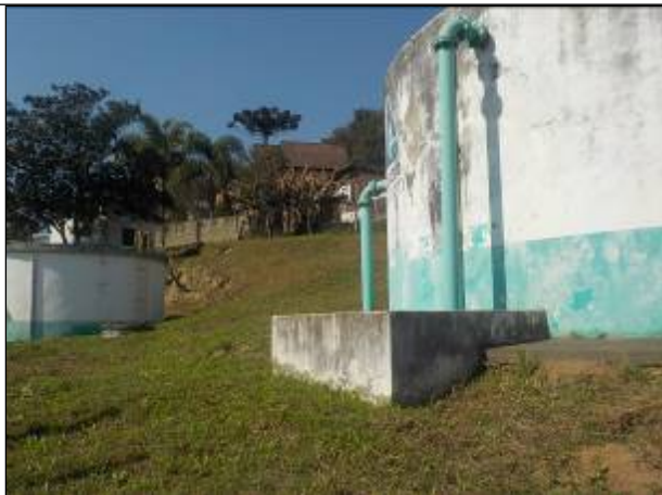
Figura 29: Vista dos Reservatórios R1 de 200 m 3 e R2 de 75 m 3 .
