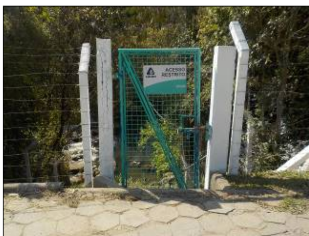
Figura 9: Escada de acesso à Área de Captação e respectiva identificação.
