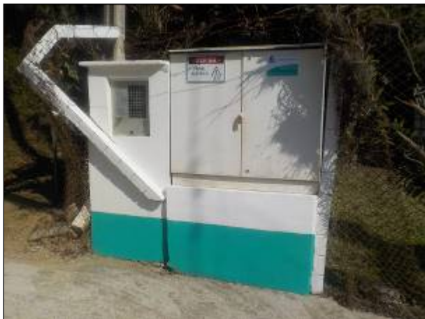
Figura 27: Vista da área externa, do Booster do Caeté, localizado junto a ETA, levam a água tratada para residências nas proximidades (em direção ao interior)
