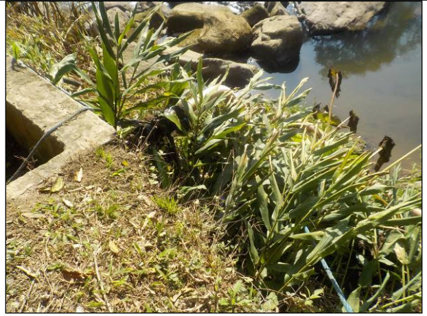
Figura 12: Vista da parte estrutural da captação, sem isolamento.
