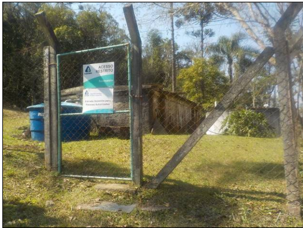
Figura 37: Vista da entrada para o Reservatório R4.
