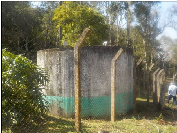
Figura 39: Vista do Reservatório R4, cercamento em boas condições.
