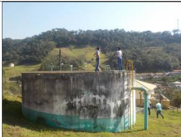
Figura 30: Escada de acesso dos operadores para o reservatório R2.
