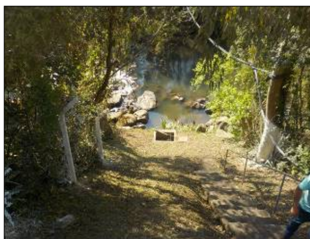
Figura 10: Vista da ETA a partir da escada de acesso à Área de Captação de Alfredo Wagner.
