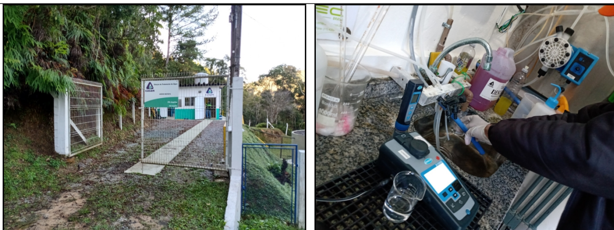
Figura 2 - Visão geral da ETA e coleta de amostras de água tratada na saída da ETA (01/07/2021).
