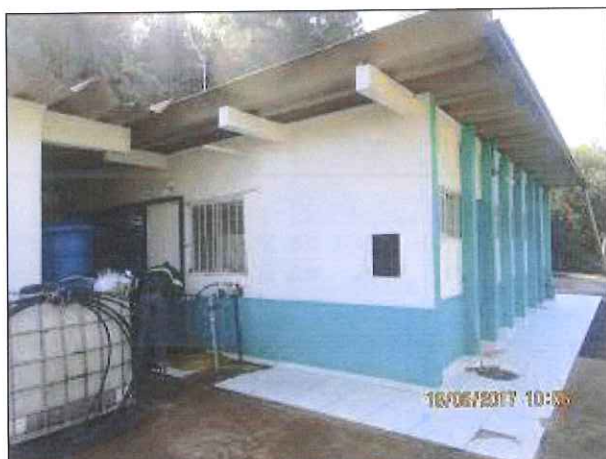
Figura 2: Imagem da ETA Catanduvras.
