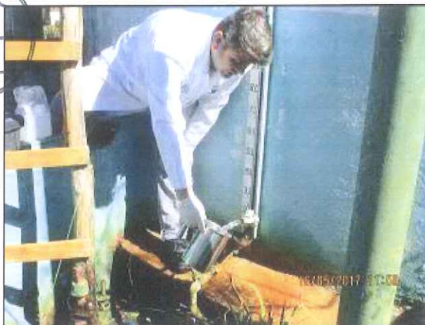
Figura 6: Imagem do Reservatório R03, município de Catanduvás.
