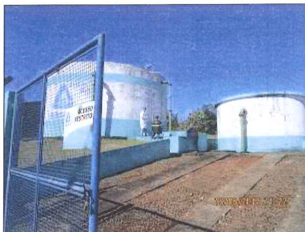
Figura 4: Imagem do Reservatório R03, município de Catanduvás.
