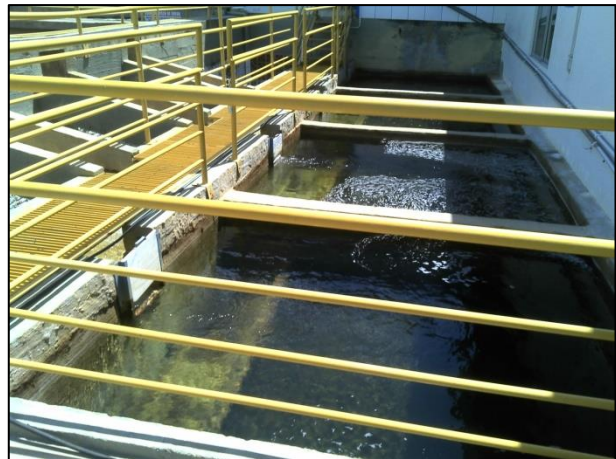
Figura 5: Vista da ETA.
