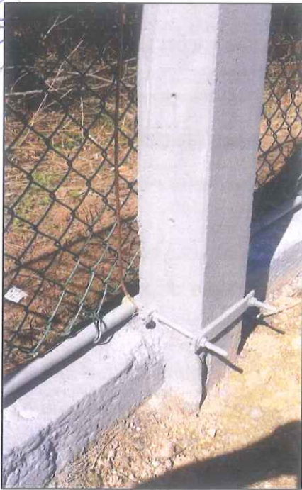
Figura 03: Foi Instalada nova cordoalha de aterramento.
