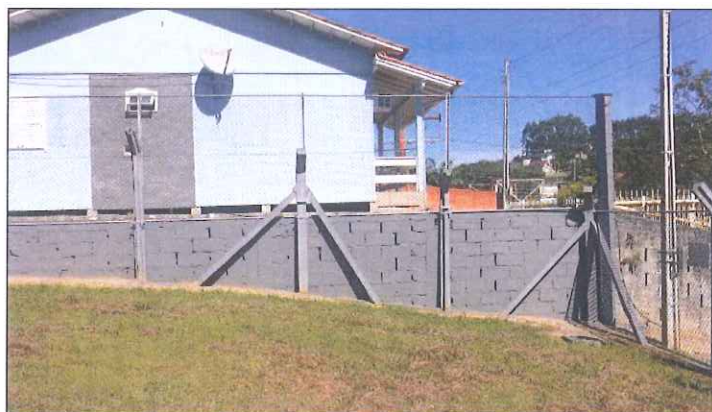
Figura 05: Altura da cerca de proteção foi readequada.
