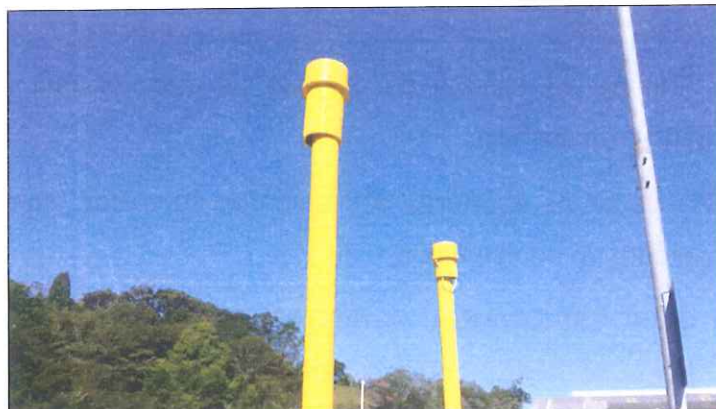
Figura 07: Foram instaladas novas ponteiras.
