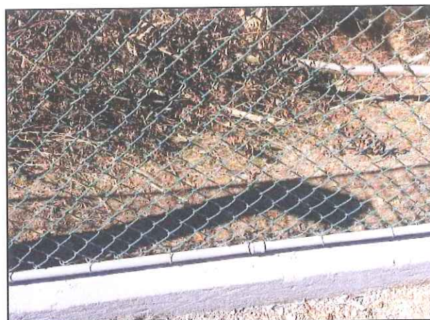
Figura 02: Fixação da tela foi restabelecida.
