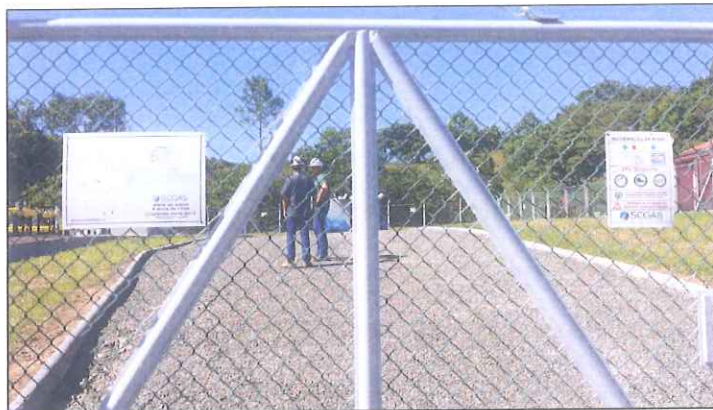
Figura 06: Placas com mapas e informações de riscos foram instaladas na estação.
