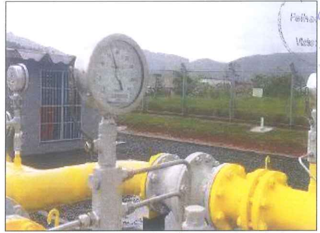
Figura 11: Alavancas de válvulas reinstaladas corretamente.
