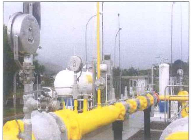
Figura 13: Alavancas de válvulas reinstaladas corretamente.
