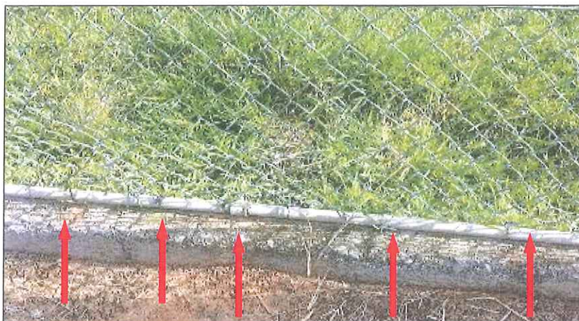
Figura 01: Concessionária aumentou a quantidade de pontos de fixação da parte inferior da tela, conforme determinação.
