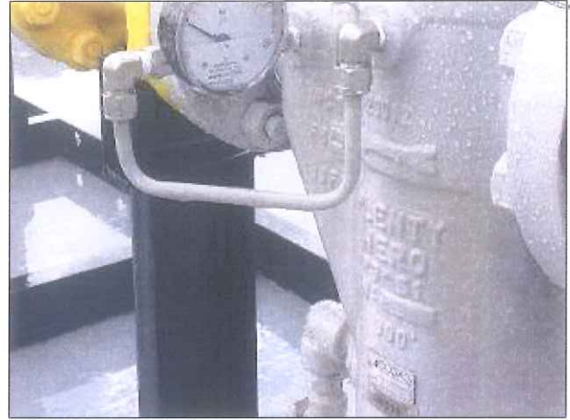
Figura 05: Feito readequação na pintura da válvula.
