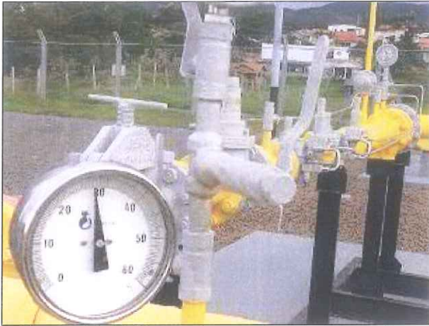
Figura 04: Feito readequação na pintura da válvula.
