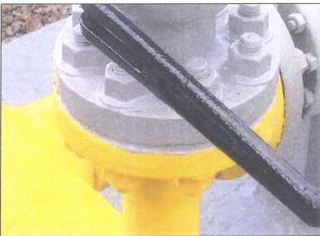
Figura 06: Feito readequação na pintura da conexão.
