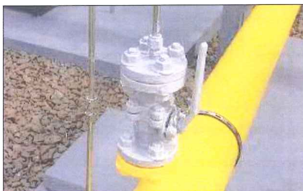
Figura 03: Feito readequação na pintura da válvula.
