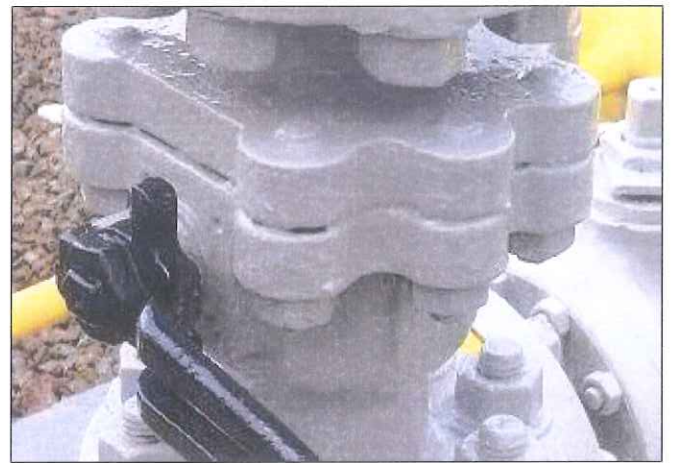
Figura 07: Feito readequação na pintura da conexão.
