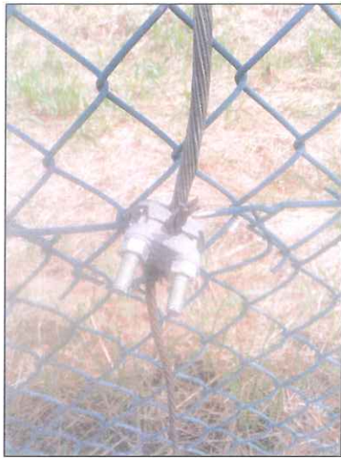
Figura 02: Conector de aterramento.
