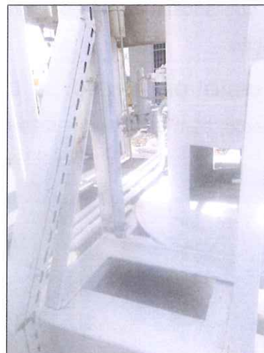
Figura 05: Suporte do novo sistema de odoração.
