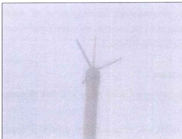
Figura 14: Para-raios com a haste central.
