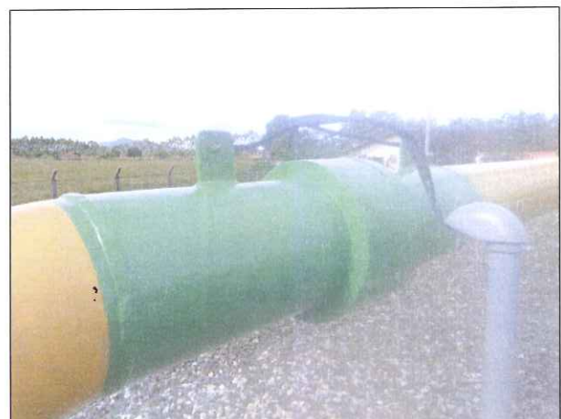
Figura 12: Junta de isolamento.
