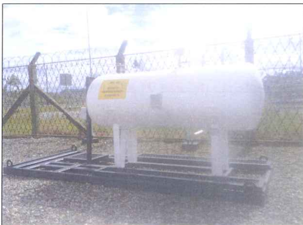
Figura 04: Novo sistema de odoração.
