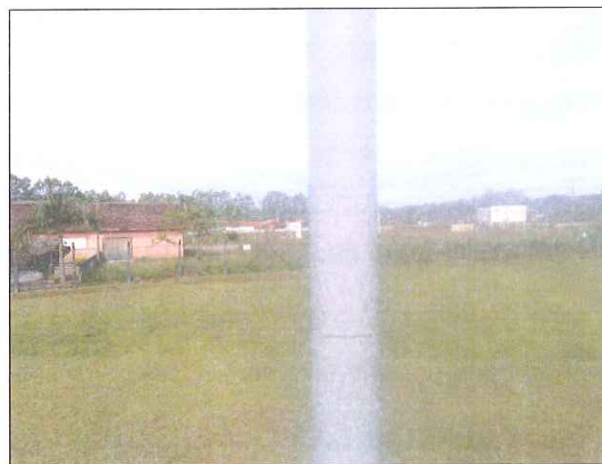
Figura 15: Situação atual do poste do SPDA. [assinatura]
