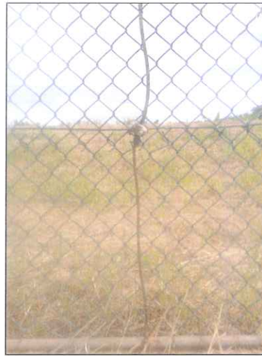
Figura 03: Conector de aterramento.
