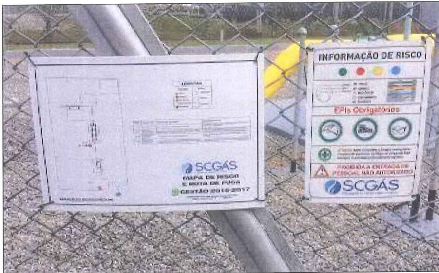
Figura 05: Mapa e informações de risco instaladas na estação.
