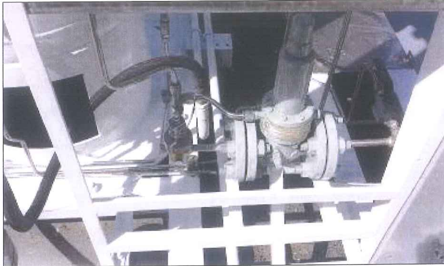
Figura 02: Estrutura do sistema de odoração (SDO) após manutenção.
