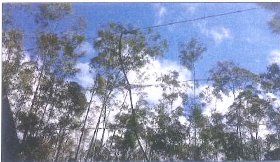
Figura 01: Substituição dos conectores de aterramento e arame farpado.
