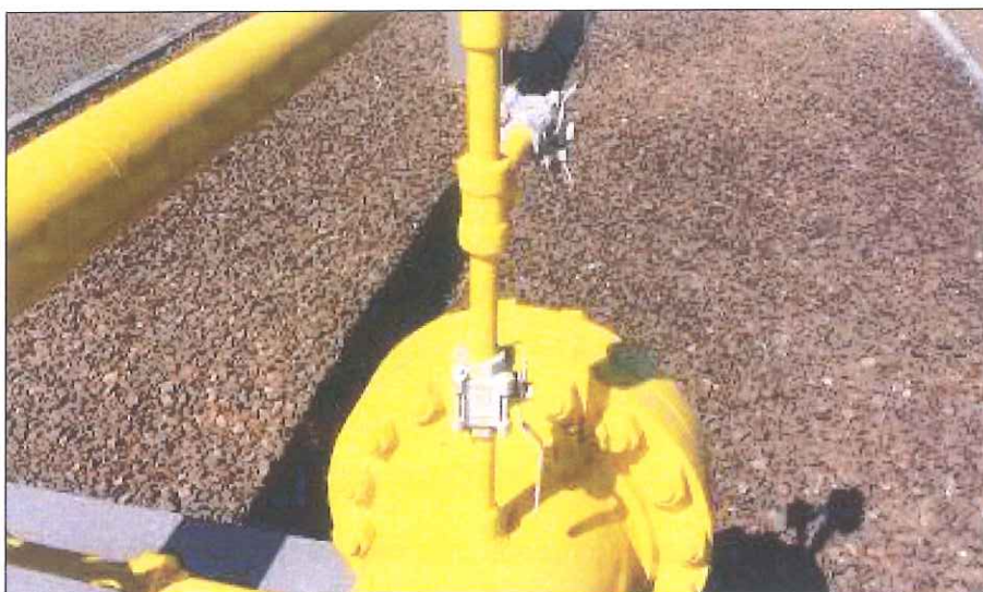
Figura 04: Pintura da válvula foi refeita.
