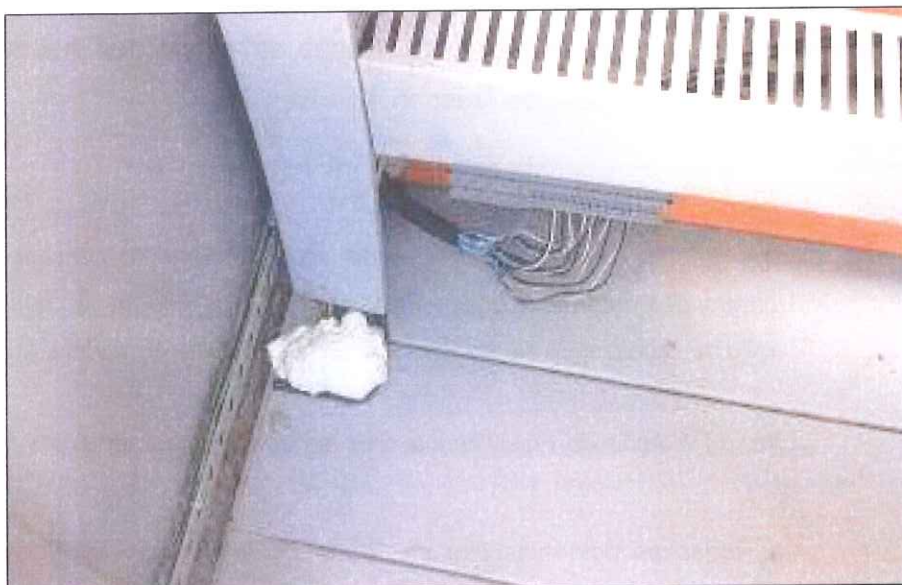
Figura 07: Aberturas das entradas de cabos foram vedadas com espuma expansiva.
