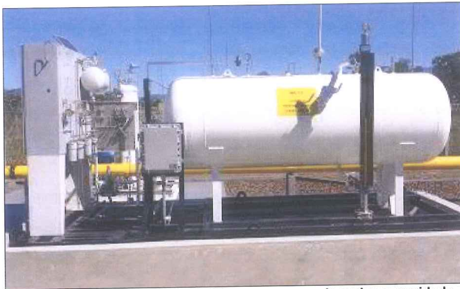
Figura 02: SDO antigo substituído por um novo de maior capacidade.
