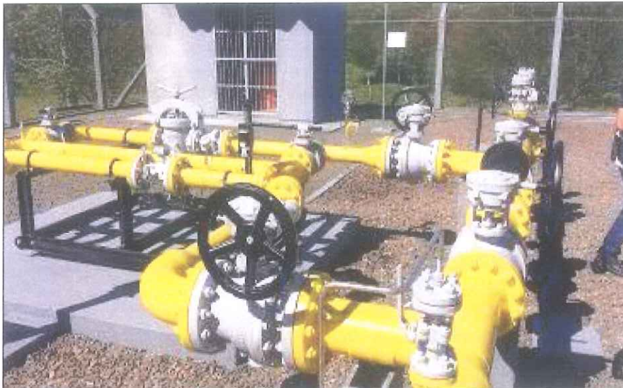
Figura 03: Volantes de válvulas restaurados.
