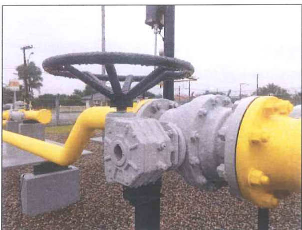
Figura 07: Válvula com pintura adequada.
