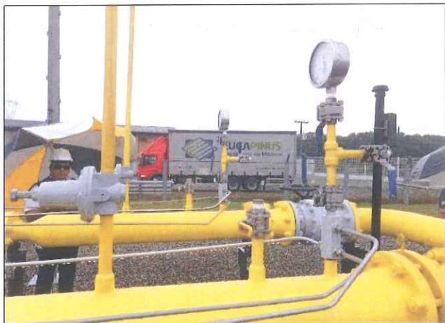
Figura 11: Registros Novos e alavancas em boas posições.
