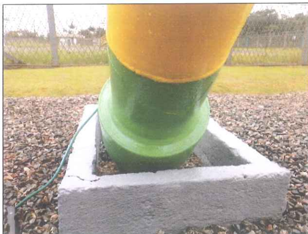
Figura 10: Tubulação com pintura nova.
