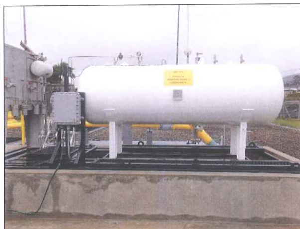
Figura 06: Sistema de Odoração novo (2.000 L).
