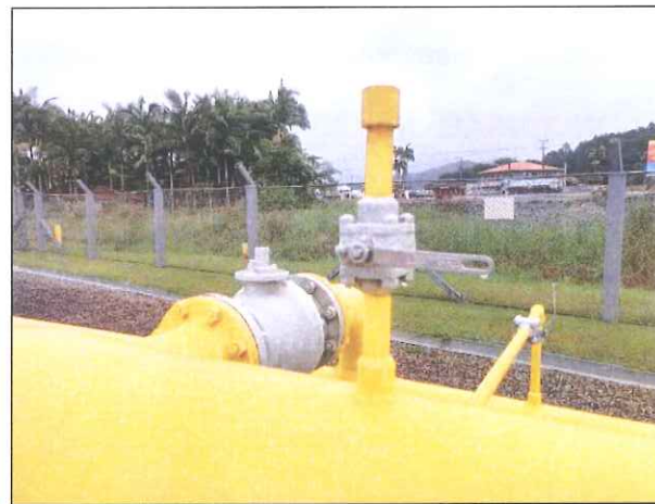
Figura 12: Válvula e registro bem pintados.
