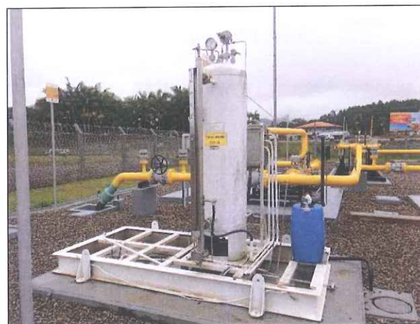
Figura 08: Sistema de Odoração antigo.
