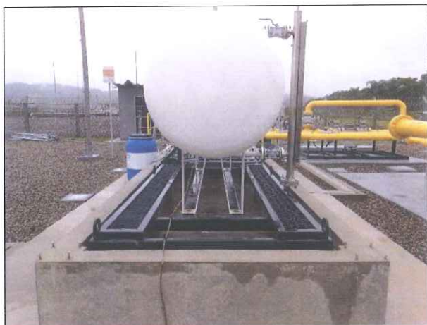
Figura 05: Sistema de Odoração novo.
