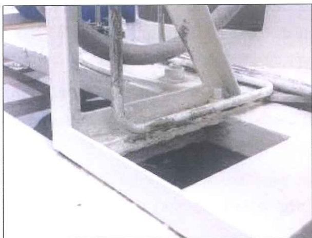
Figura 03: Pintura e convertedor de ferrugem.
