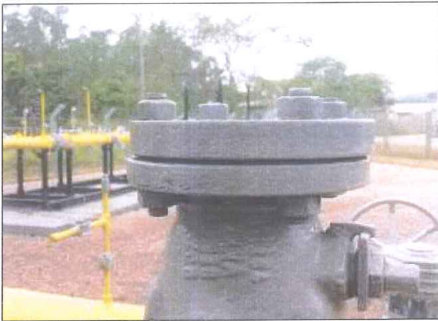
Figura 05: Conexão com nova pintura.
