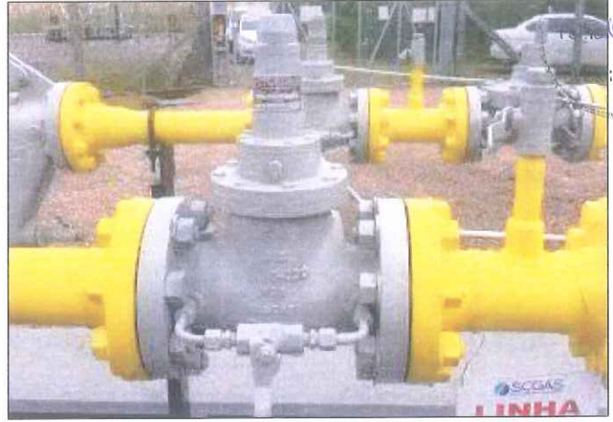
Figura 06: Equipamentos com novas pinturas.
