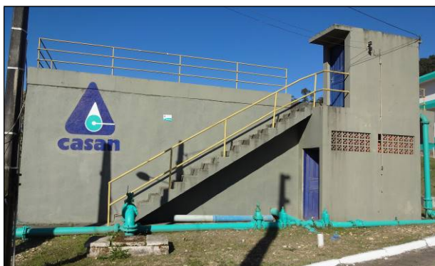
Figura 13: Recomendação 19, vista da identificação da concessionária no Reservatório da ETA.
