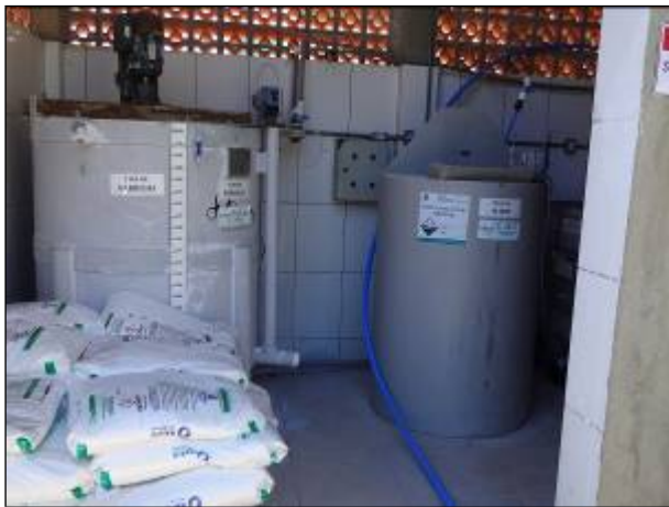
Figura 9: Recomendação 17, foi disposto um local adequado para armazenamento e acondicionamento dos produtos químicos e materiais utilizados na ETA Compacta.
