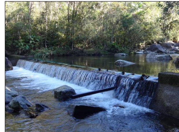
Figura 4: Recomendação 07, isolamento da área de captação, com instalação de cercas e cadeados.
