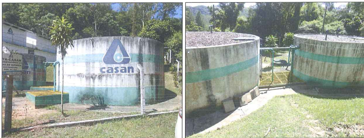
Figura 9: Reservatórios R01 e R02 da ETA
