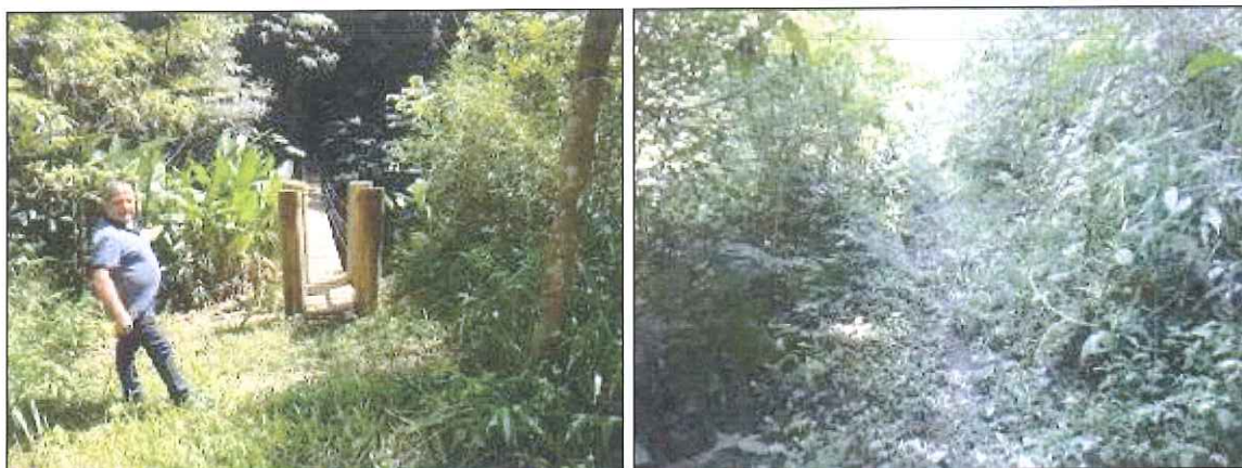
Figura 4: Nova passarela e o acesso a captação
