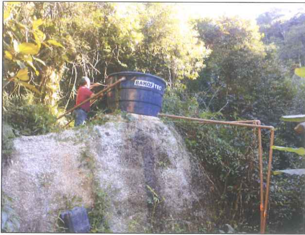
Figura 7: Sistema Alternativo Coletivo de Abastecimento de Água para Consumo Humano da comunidade de Salto, município de Major Gercino.
