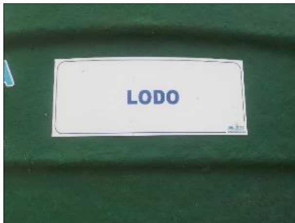
Figura 19: Vista da placa indicativa do equipamento.
