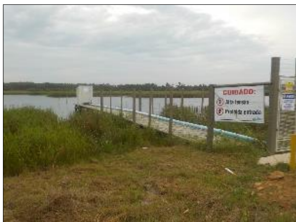
Figura 4: Vista da Área de Captação e acesso à ERAB Lagoa do Guairacá, com sinalização e cercamento adequados.
