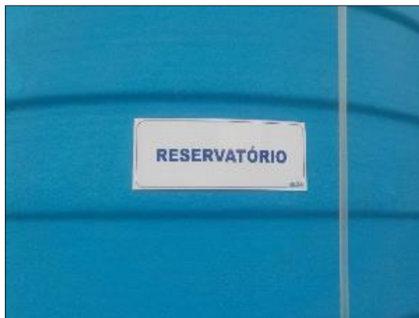
Figura 49: Vista em detalhe da placa indicativa do reservatório.
