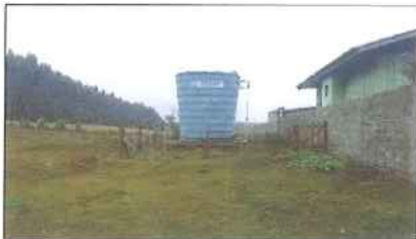
Figura 9: Imagem dos Reservatórios R2/R3, Bairro Santa Mônica.
