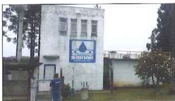
Figura 3: Imagem da ETA Salto Canoinhas, município de Papanduva.
