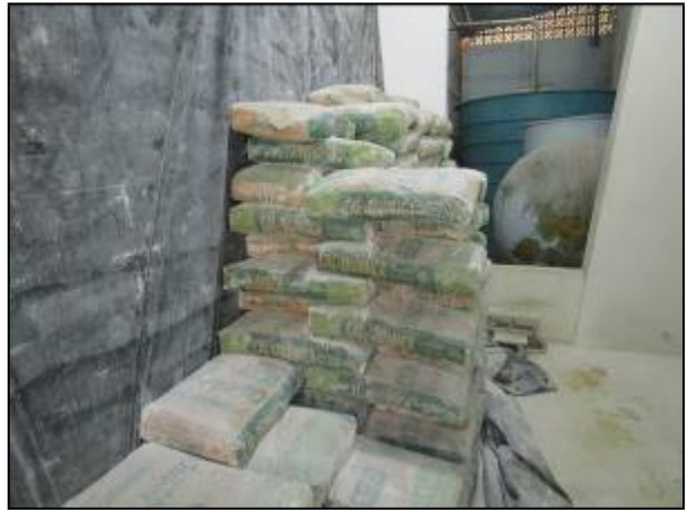
Figura 25: Produtos químicos dispostos no Almoarifado da ETA I.
