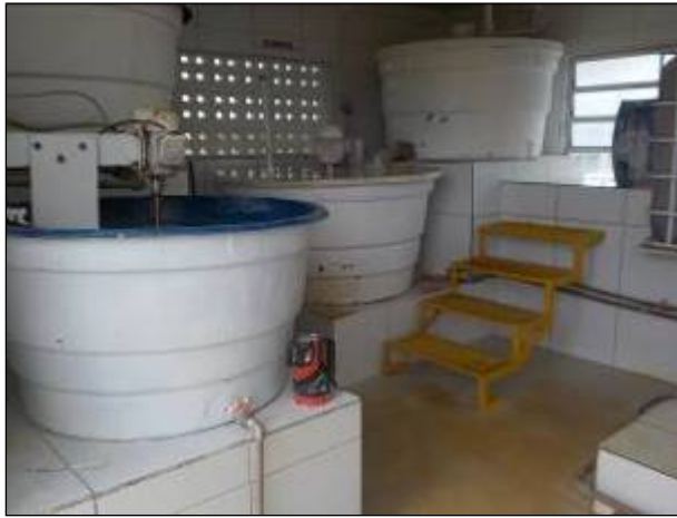
Figura 23: Casa de química na ETA I.
