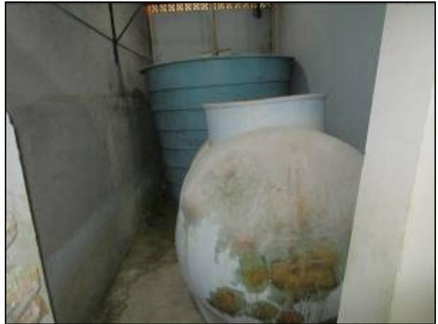
Figura 26: Produtos químicos dispostos no Almoarifado da ETA I.
