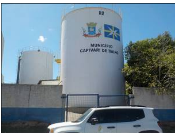
Figura 15: Vista de entrada do R 1 e R 2.
