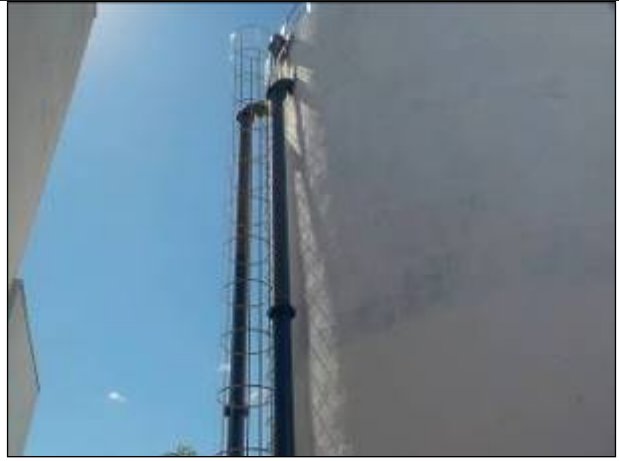
Figura 18: Escada de acesso ao R 1, totalmente reparada.
