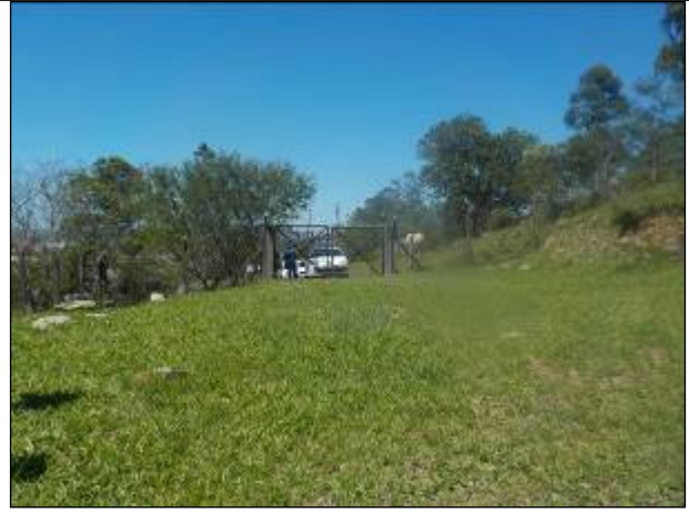
Figura 24: Vista do acesso, e o portão de acesso, ao Reservatório R 3.
