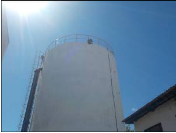
Figura 17: Reservatório R 1, está em reforma, já licitado, será esvaziado para verificação da parte interna.
