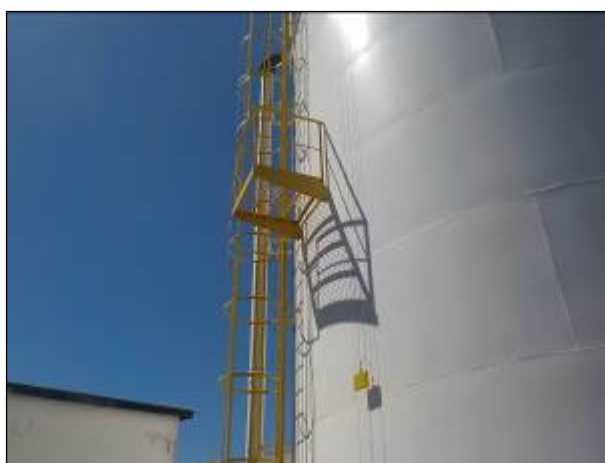
Figura 16: Detalhe da escada de acesso ao Reservatório R 2.
