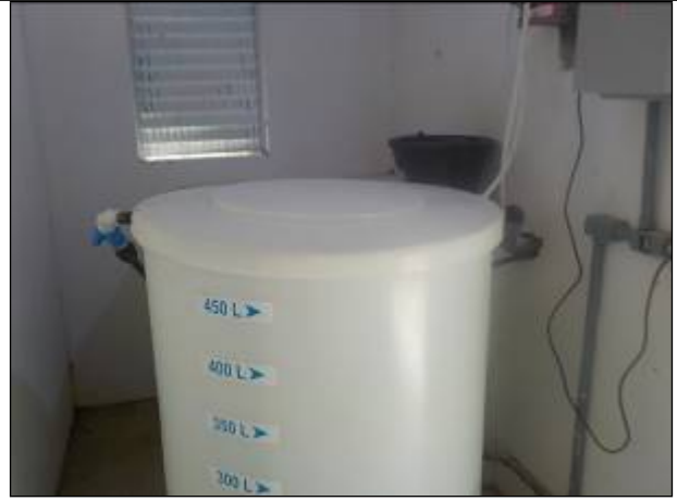
Figura 10: Recipiente contendo a mistura para a desinfecção da água bruta que chega até a ETA de Varginha.
