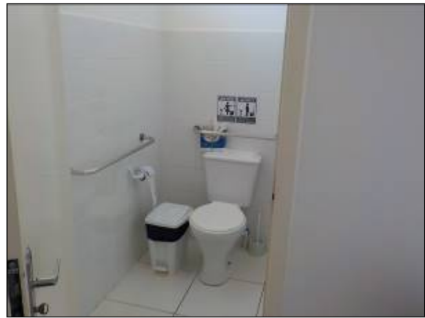
Figura 4: Banheiro Compartilhado no Escritório de Atendimento.
