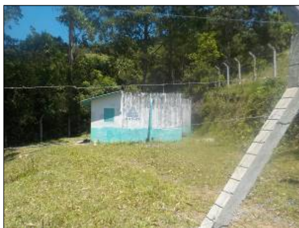
Figura 8: ETA de Varginha e a vista externa de sua Casa de Química, em funcionamento. No ano de 2021 a Concessionária pretende desativar a estrutura e fazer a desinfecção diretamente no Poço Varginha.
