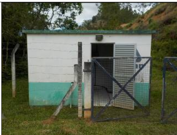
Figura 21: Vista da parte externa da ETA Rio Gabiroba, cercamento e portão em boas condições.
