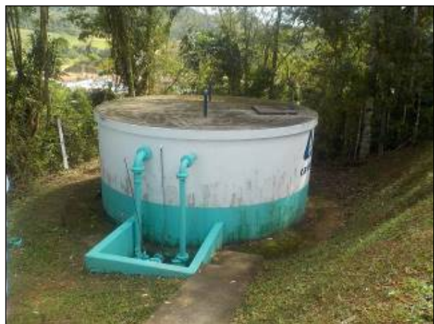
Figura 14: Vista geral do Reservatório R2 (20 m³), de concreto, em boas condições, localizado junto à ETA São Martinho.
