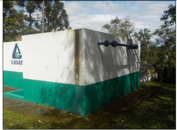
Figura 16: Estrutura disponível no terreno da ETA São Martinho.
