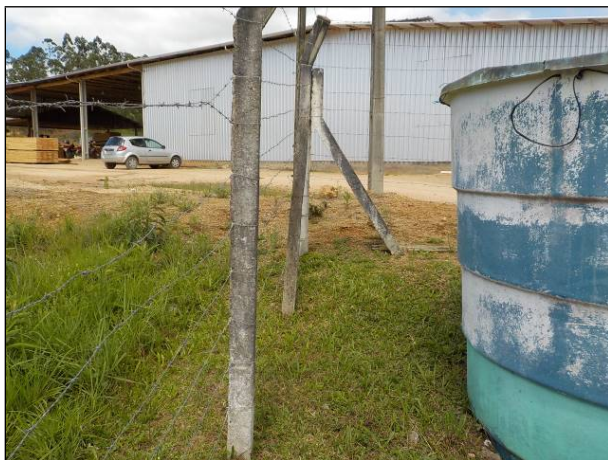
Figura 29: Vista de parte do reservatório Gabiroba e o cercamento em boas condições.
