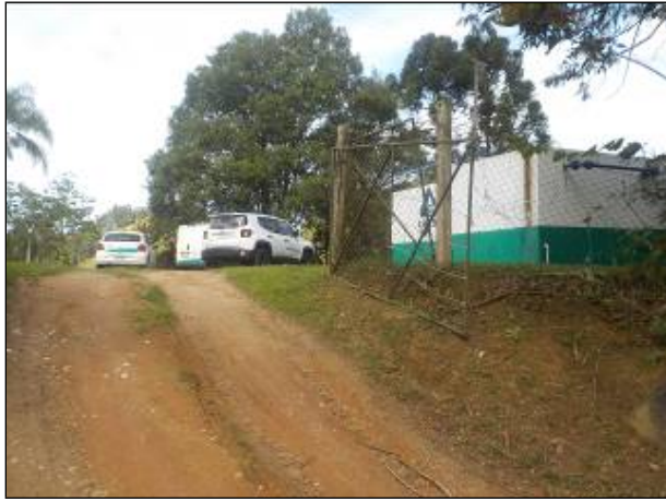
Figura 5: Vista da entrada da ETA São Martinho, no Centro do município.
