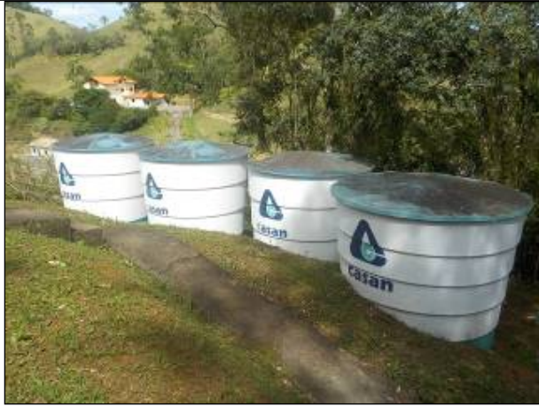
Figura 15: Vista Geral dos Reservatórios R1, R3, R4 e R5, interligados junto a ETA (40m 3 ), com tampas superiores e estruturas laterais em boas condições. Interligados entre eles e com o R2.
