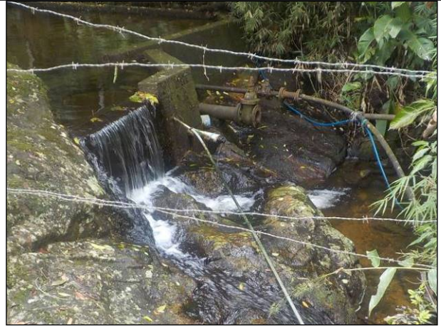
Figura 4: Vista em detalhe da captação do Rio Cachoeira.
