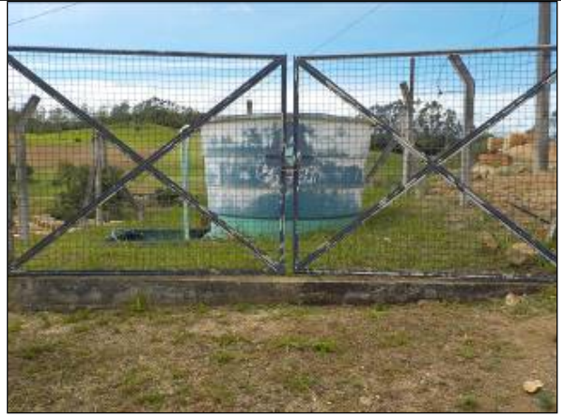
Figura 28: Vista da entrada do Reservatório Gabiroba, cadeado, porém sem placa ou pintura indicativa da unidade.
