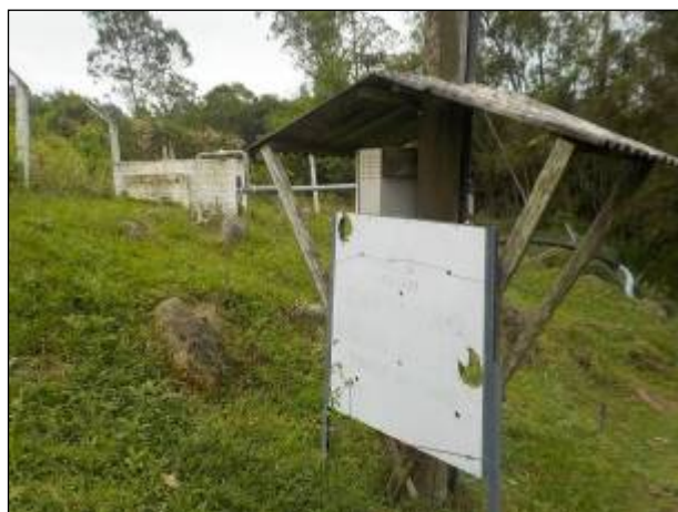
Figura 70: Vista da área da antiga captação superficial no rio Coruja, com os equipamentos desativados (outubro 2020).
