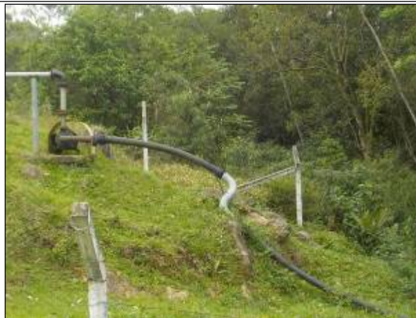
Figura 69: Vista da área da antiga captação superficial no rio Coruja, com os equipamentos desativados (outubro 2020).
