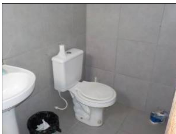
Figura 16: Vista interna do banheiro 2, de uso compartilhado (outubro 2020).
