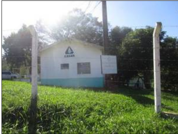
Figura 21: Placa indicativa da ETA Treze de Maio, ao fundo a Casa de Química e laboratório (junho 2019).
