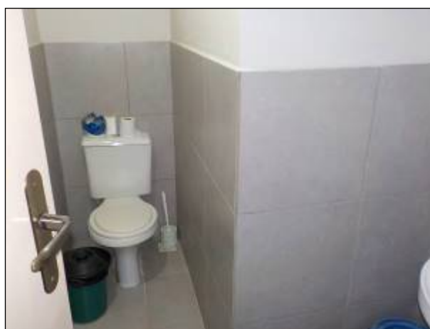
Figura 14: vista interna do banheiro 1, de uso compartilhado (outubro 2020).
