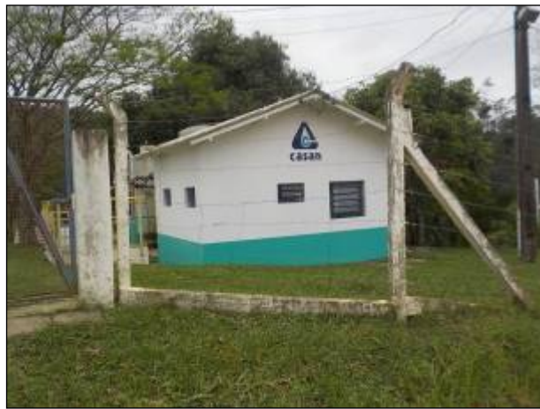
Figura 41: Vista externa da ETA Treze de Maio a partir da entrada (outubro 2020).
