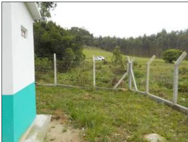
Figura 61: Vista de parte do abrigo, à esquerda na imagem, e do cercamento da área (outubro 2020).
