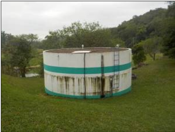
Figura 64: Vista do Reservatório R 01, localizado junto à ETA Treze de Maio (outubro 2020).
