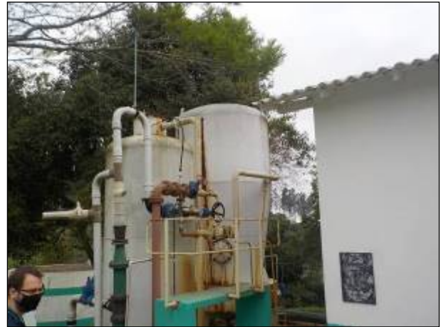
Figura 46: Parte da estrutura da ETA, filtros, desativada a partir da utilização da Captação subterrânea (outubro 2020).
