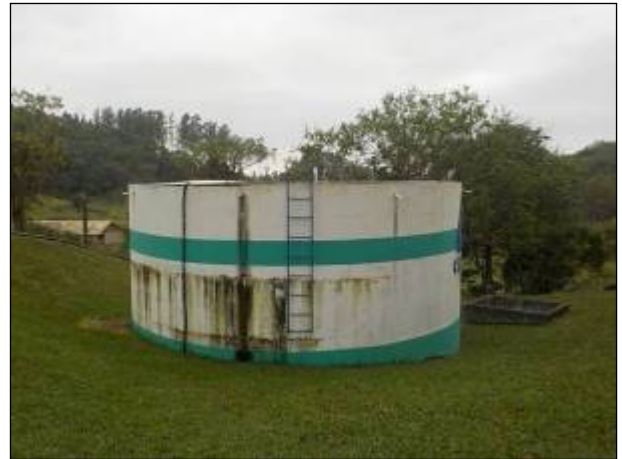
Figura 65: Vista do Reservatório R 01, localizado junto à ETA Treze de Maio (outubro 2020).
