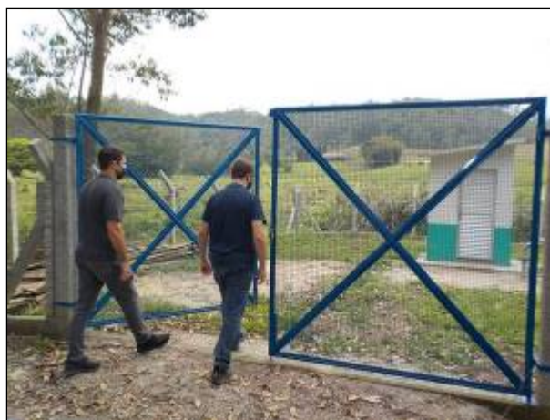
Figura 56: Portão de entrada do Poço 01, localizado na Linha Fragnani, cadeado mas sem as placas de identificação e restrição de acesso, ao fundo imóvel que abriga o quadro de comando e aparelho medidor de vazão (outubro 2020).
