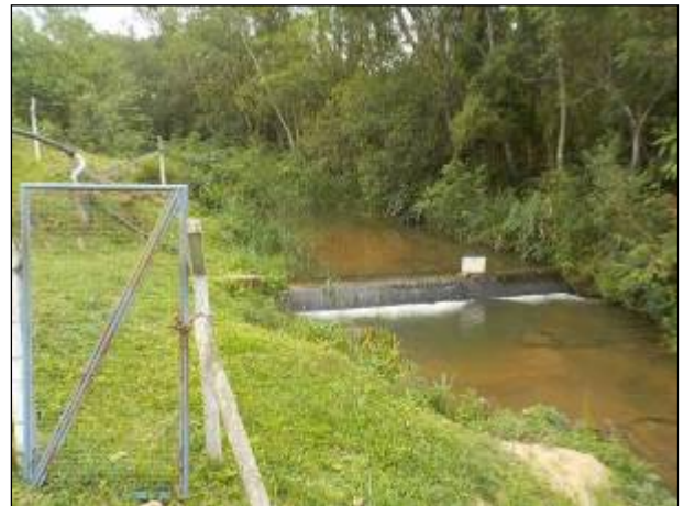
Figura 67: Vista da área da antiga captação superficial no rio Coruja (outubro 2020).
