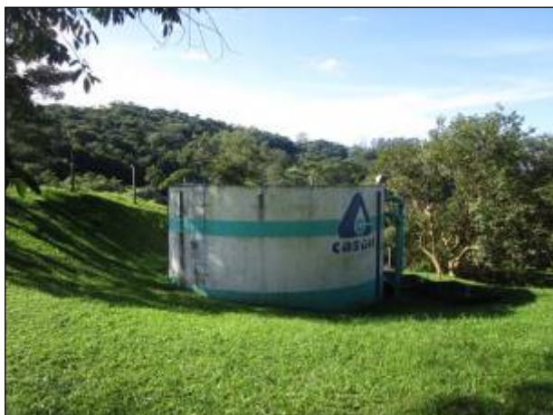
Figura 31: Reservatório R 01, junto à ETA Treze de Maio (junho 2019).
