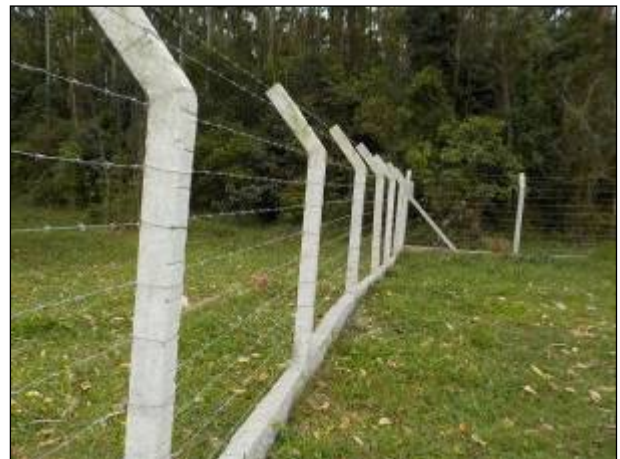
Figura 62: Vista de parte do cercamento no entorno da área de captação do Poço 01 (outubro 2020).
