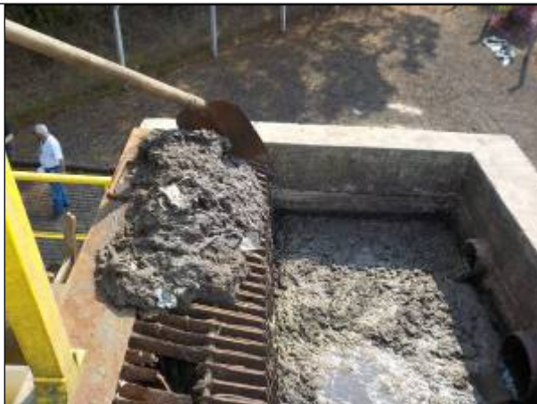
Figura 98: Chegada do esgoto bruto na ETE de Catanduvras no momento da visita técnica de fiscalização.
