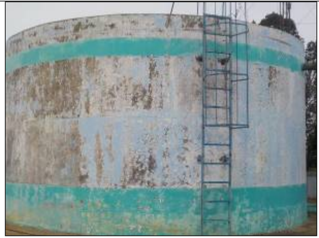
Figura 68: Vista parcial do reservatório R-02, com capacidade de reservação de 150 m 3 , detalhando sua escada de acesso.
