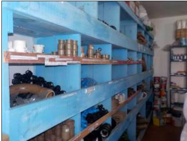
Figura 17: Vista do interior do almoxarifado contendo as peças para manutenção dos SAA e SES.
