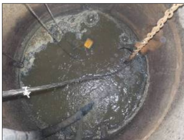
Figura 126: Vista do poço de sucção da elevatória de esgoto EEE 01
