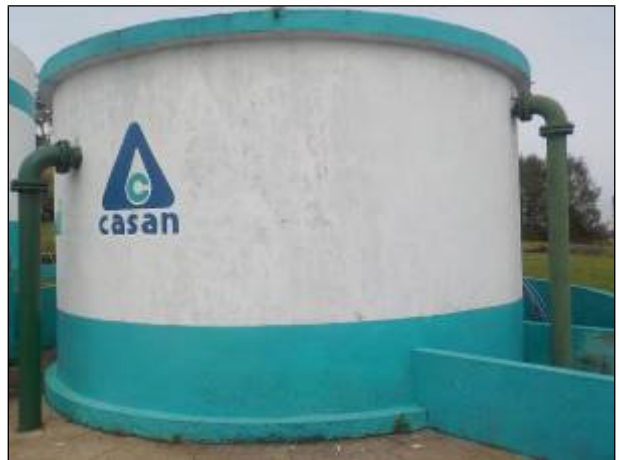
Figura 76: Vista parcial das tubulações de extravasamento e de entrada de água tratada do reservatório R-01, atualmente desativado.
