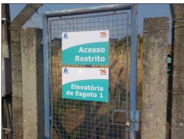
Figura 123: Placas de restrição de acesso e indicação da unidade afixadas no portão de entrada da EEE 01
