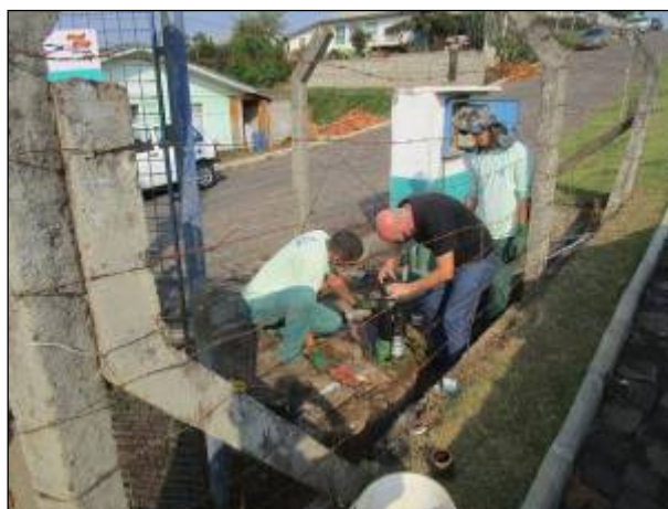
Figura 132: Trabalho de troca da bomba na EEE 02, novo equipamento com a mesma potência.
