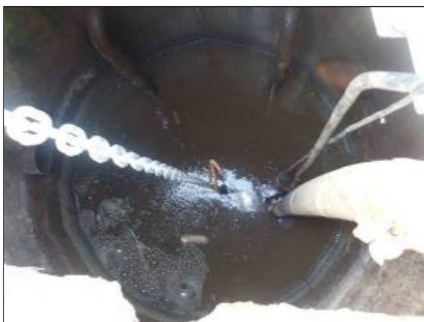
Figura 141: Detalhe do Poço da EEE 04.
