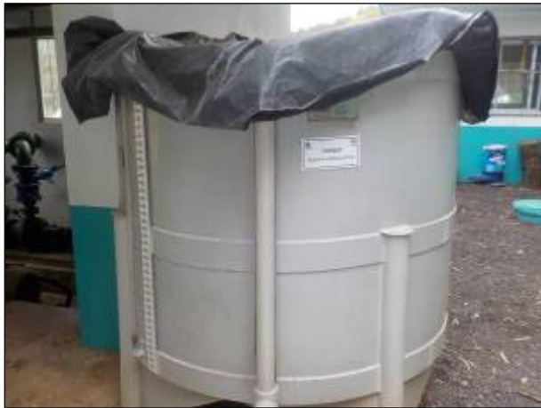
Figura 41: Tanque contendo o ácido fluossilícico, utilizado no processo de fluoretação.
