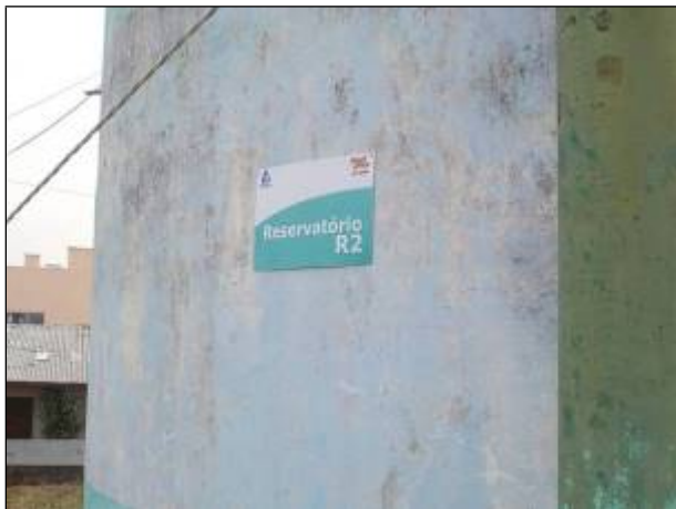
Figura 63: Detalhe da placa indicativa da unidade, o reservatório R-02
