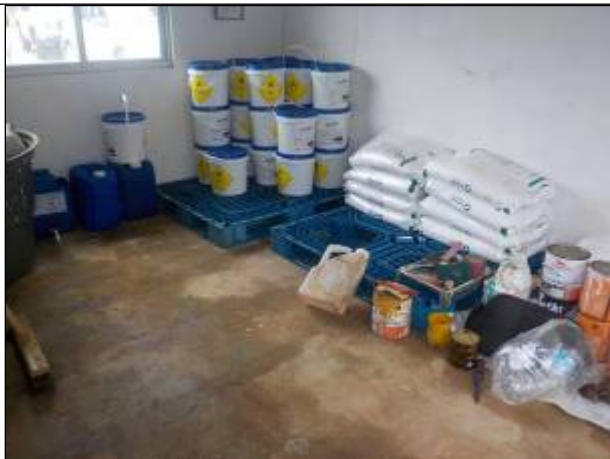
Figura 49: Vista interna da área destinada a armazenar os produtos químicos utilizados no tratamento da água na ETA Catanduvas.
