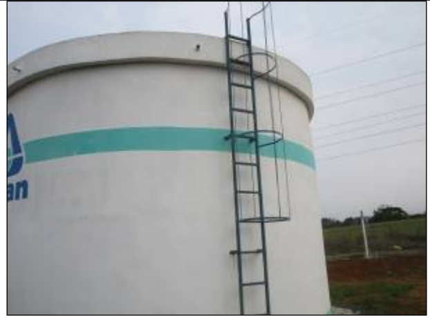
Figura 86: Vista parcial do reservatório localizado no Casagrande, ainda não fazendo parte do SAA; detalhe da escada de acesso à área superior.
