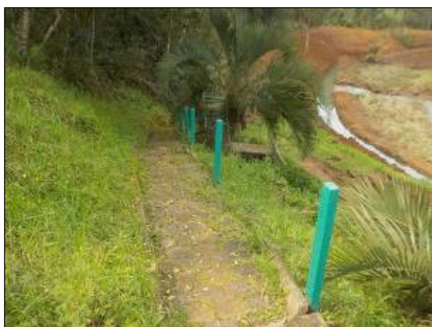
Figura 21: Escada de acesso à Área de Captação vista a partir da ETA Catanduvras.
