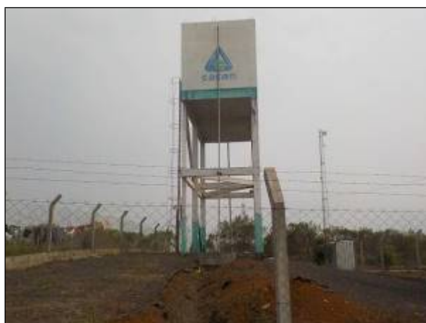
Figura 82: Vista parcial da área frontal do reservatório R-07, em primeiro plano o cercamento do terreno.
