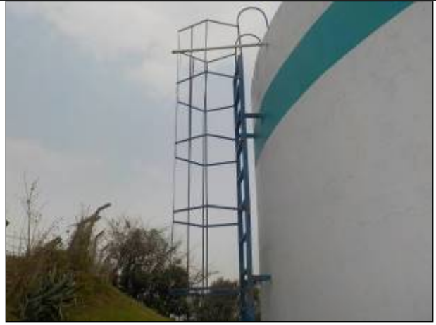
Figura 74: Detalhe da escada de acesso à área superior do reservatório R-03.
