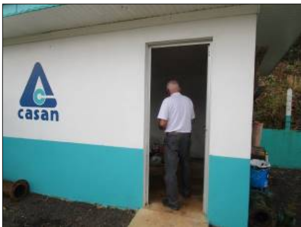
Figura 47: Vista externa da área destinada a armazenar os produtos químicos utilizados no tratamento da água na ETA Catanduvás.
