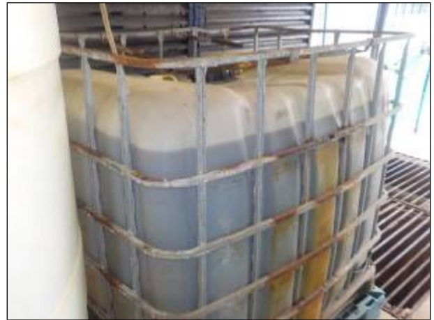
Figura 42: Tanque contendo o policloreto de alumínio (PAC), utilizado no tratamento da água para auxiliar na coagulação dos sólidos.
