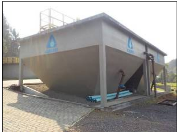
Figura 108: Vista parcial do local onde é realizada a decantação secundária na ETE Catanduvas.
