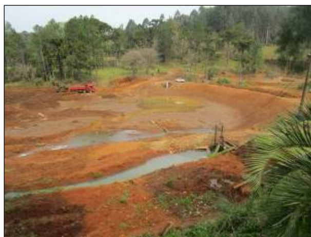
Figura 24: Maquinário fazendo a dragagem da barragem do Lajeado Catanduvras, ao fundo. Em primeiro plano a estrutura provisória montada para a captação da água bruta.
