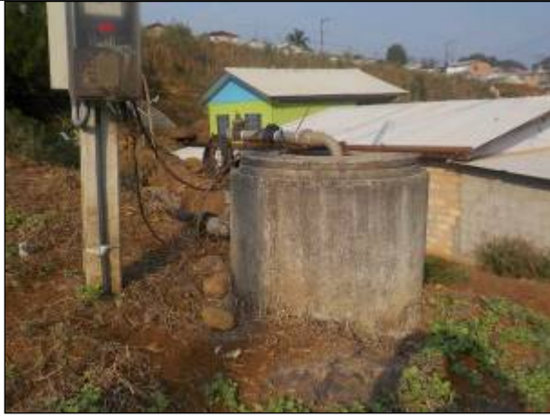
Figura 151: Vista parcial da EEE 07, o qual eleva o esgoto até a EEE 06, em área mais elevada do mesmo bairro.
