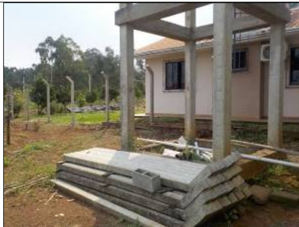
Figura 80: Detalhe dos palanques curvos que serão o suporte do cercamento futuro da área do R-06; ao fundo os mourões de concreto já estão fixados, restando a cerca metalizada para isolar a área e manter a segurança do local.
