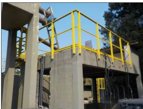
Figura 100: Vista lateral do local onde deveria estar o equipamento que realiza o tratamento preliminar do esgoto, no momento da vistoria indisponível.
