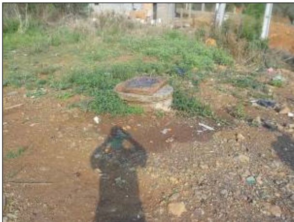
Figura 149: Vista da EEE 06, localizada em área próxima à EEE 04, sem cercamento e placas próxima ao Conj. Habit. Silvio Bitencourt.
