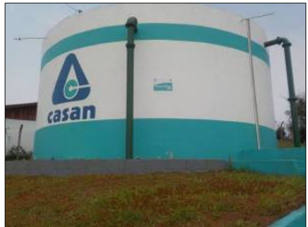
Figura 72: Vista parcial do reservatório R-03, o qual tem capacidade de reservação da água tratada de 250 m 3 .
