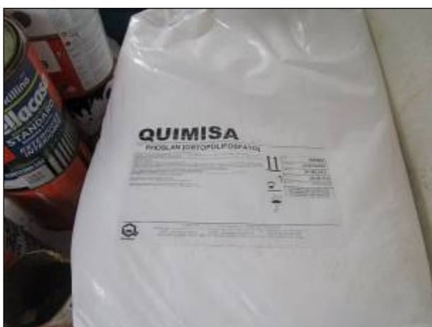
Figura 51: Detalhe do armazenamento do Ortopolifosfato, um desincrustante utilizado no tratamento da água na ETA Catanduvas.
