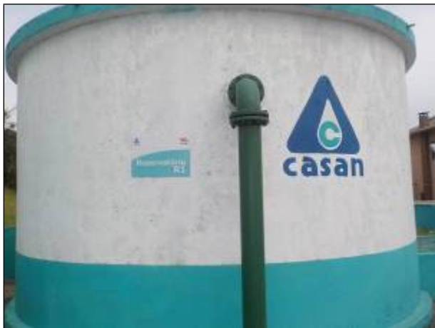
Figura 75: Vista parcial do reservatório R-01, junto ao R-03, que atualmente está desativado.
