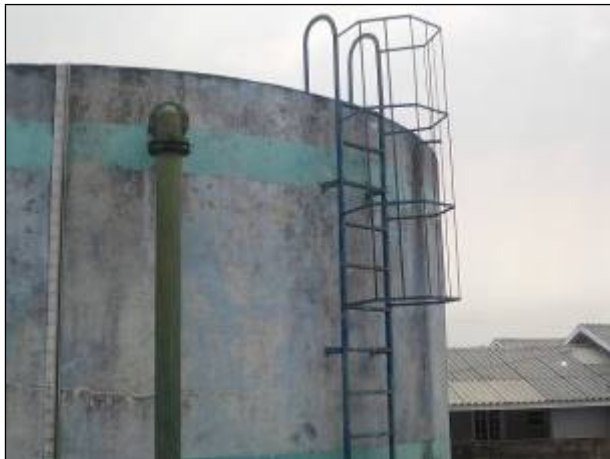
Figura 65: Detalhe da escada de acesso e da tubulação de entrada de água tratada no R-02.
