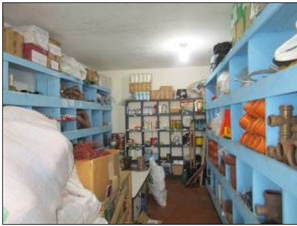
Figura 15: Vista do interior do almoxarifado contendo as peças para manutenção dos SAA e SES.
