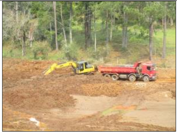
Figura 26: Detalhe do maquinário realizando a dragagem da barragem do Lajeado Catanduvras.
