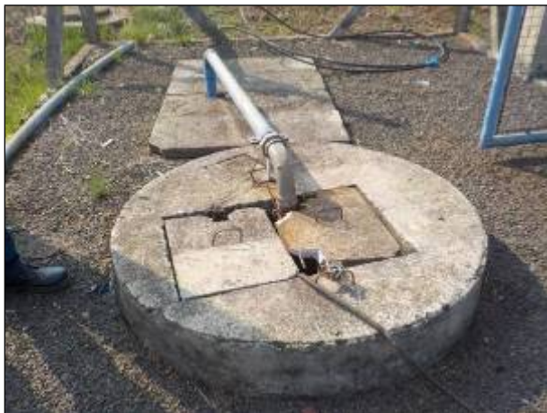
Figura 137: Vista da área interna da EEE 03.
