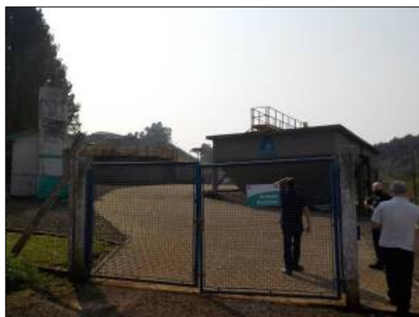
Figura 96: Vista do portão de acesso de veículos da ETE Catanduvás, afixada neste placa de restrição de acesso ao local.
