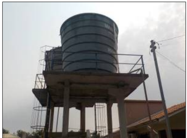
Figura 78: Vista parcial da estrutura e dos reservatórios de fibra, os quais podem armazenar 20 m 3 de água cada.
