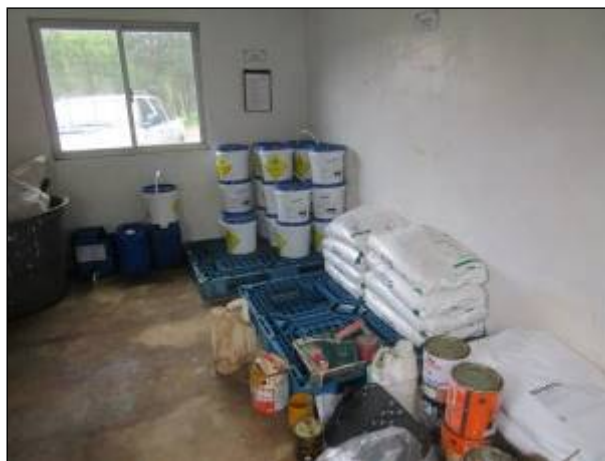
Figura 48: Vista interna da área destinada a armazenar os produtos químicos utilizados no tratamento da água na ETA Catanduvás; todos sobre piso plástico elevado.
