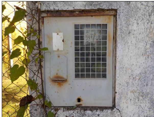
Figura 11: Equipamento medidor de energia das unidades, sem cadeado e lacre de proteção.
