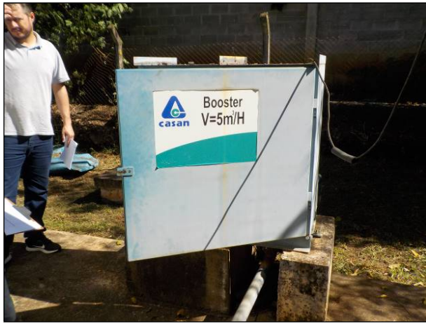
Figura 7: Vista da placa e estrutura externa do Booster 1 , no terreno da ETA.
