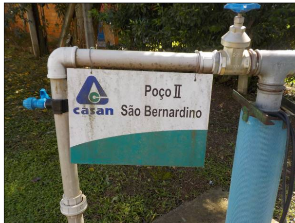
Figura 2: Poço 02 junto à ETA, placa em detalhe.
