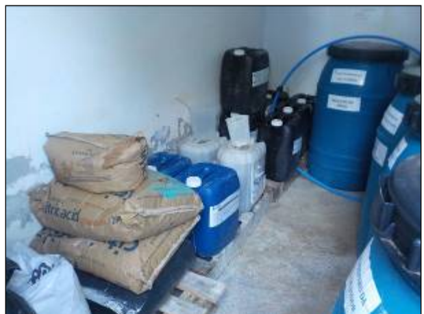
Figura 20: Armazenamento dos produtos químicos utilizados no tratamento da água na ETAU.
