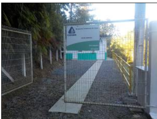
Figura 1110: Vista de entrada da Estação de Tratamento de Água por Ultrafiltração – ETAU Angelina e sua placa de identificação afixada no portão.
