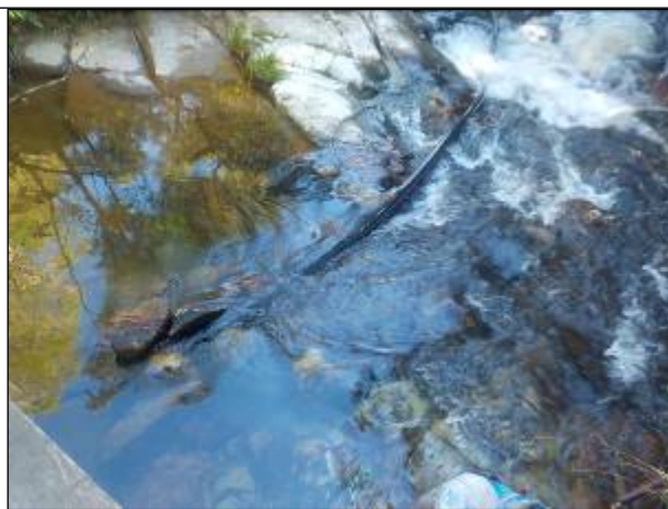
Figura 109: Melhorias a serem realizadas na área de captação, programadas para serem finalizadas até início de 2022.
