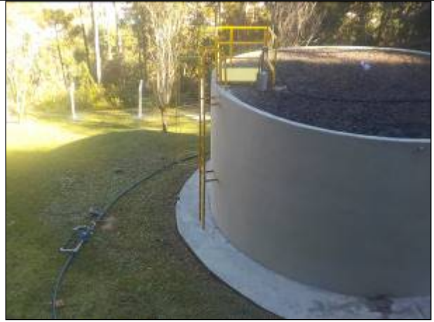
Figura 16: Vista do Reservatório com destaque da escada de acesso à parte superior, em boas condições de uso e conservação.
