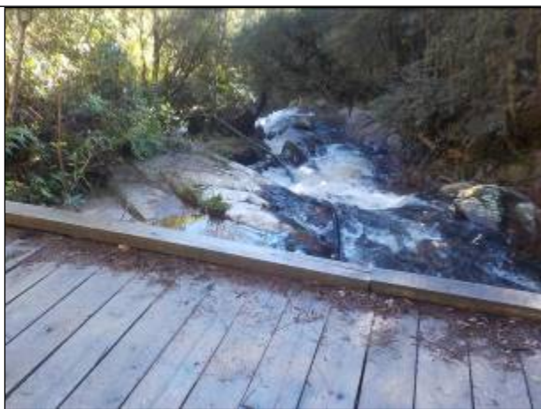
Figura 09: Vista da Captação Rio Vargem dos Pinheiros.
