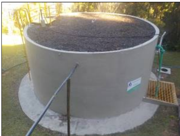
Figura 17: Vista do Reservatório com detalhes da cobertura e gradeamento, em bom estado.
