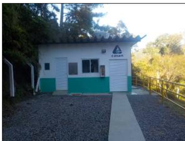
Figura 12: Vista da ETA, com imóvel pintado nas cores da companhia e acesso em ótimas condições.
