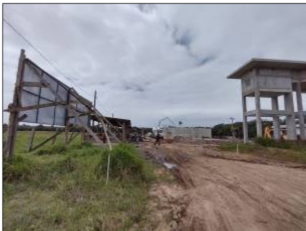
Figura 73: Vista de parte das obras da ETE Balneário Barra do Sul, em setembro de 2021.
