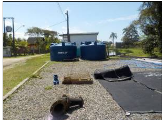
Figura 38: Vista da área interna da ETA contendo materiais que devem ser descartados ou armazenados adequadamente.
