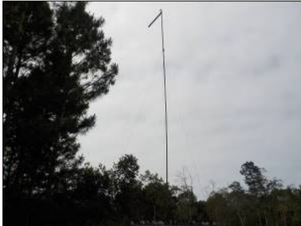
Figura 19: Vista da parte superior na ERAB 3, contendo a antena que transmite informações da unidade para os operadores na central (telemetria).
