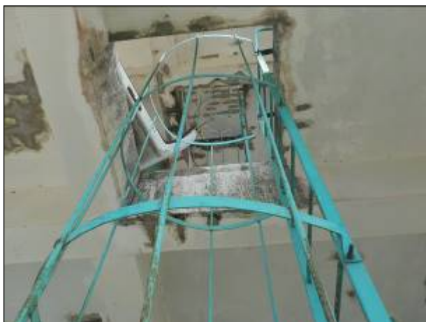
Figura 67: Vista da escada de acesso ao reservatório R1, guarda-corpo em boas condições
