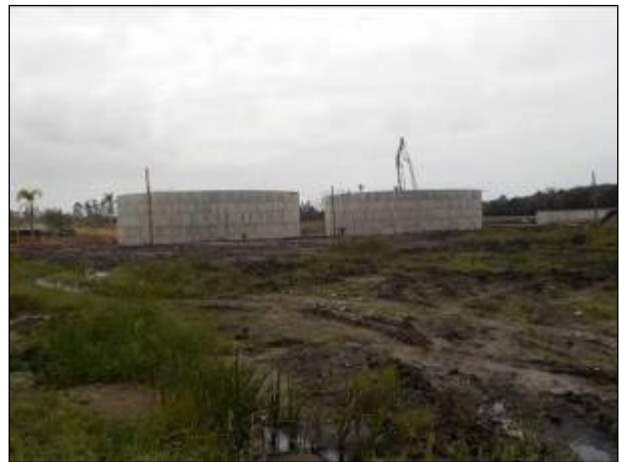
Figura 72: Vista de parte das obras da ETE Balneário Barra do Sul, em setembro de 2021.
