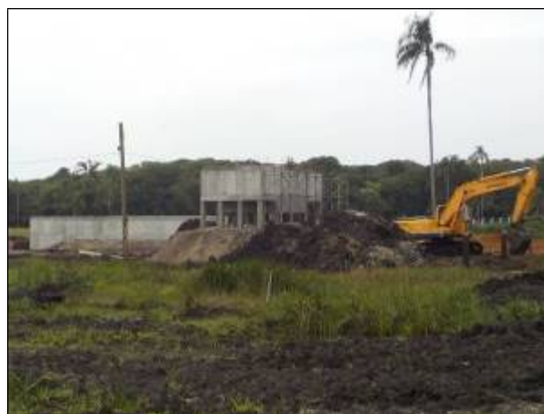
Figura 78: Vista de parte das obras da ETE Balneário Barra do Sul, em setembro de 2021.
