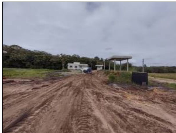
Figura 76: Vista de parte das obras da ETE Balneário Barra do Sul, em setembro de 2021.
