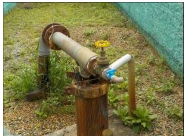
Figura 22: Vista em detalhe do Poço 1.
