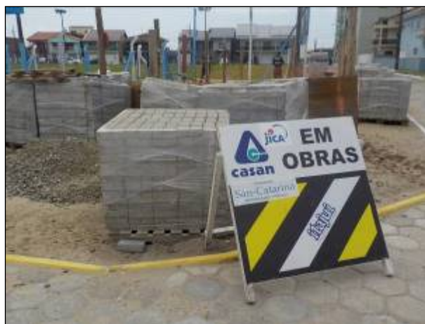
Figura 82: Vista da placa indicativa de obras na elevatória de esgoto EE-02, ainda em fase de finalização da estrutura de passeio e segurança da unidade.
