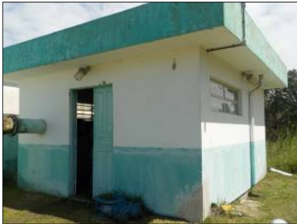
Figura 61: Vista da edificação onde está a Estação de Recalque de Água Tratada, localizada junto à ETA.
