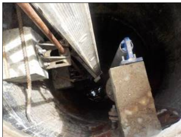
Figura 80: Vista do Poço de Visita da Elevatória EE-05, concluída, localizada na rua Ceará.
