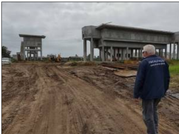
Figura 75: Equipe de fiscalização da Aresc em visita às obras da ETE Balneário Barra do Sul, em setembro de 2021.
