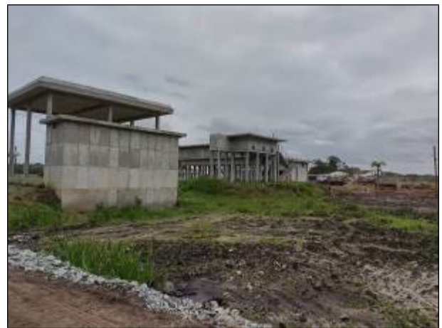
Figura 74: Vista de parte das obras da ETE Balneário Barra do Sul, em setembro de 2021.
