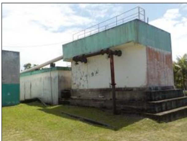
Figura 33: Vista da área interna da ETA Balneário Barra do Sul, estrutura em estado satisfatório, pintura danificada.
