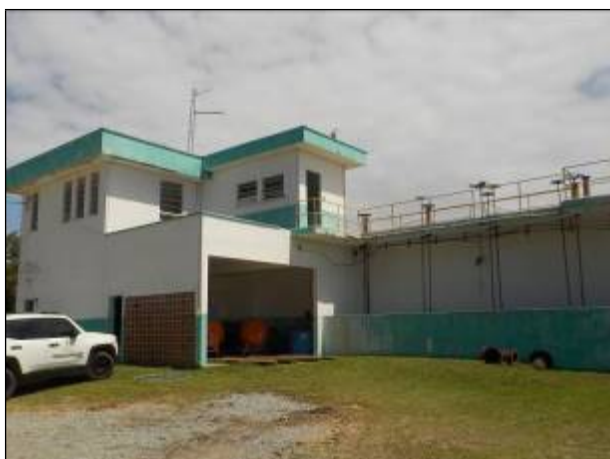
Figura 31: Vista da área interna da ETA Balneário Barra do Sul, sem placa ou pintura de identificação e acesso restrito da unidade.
