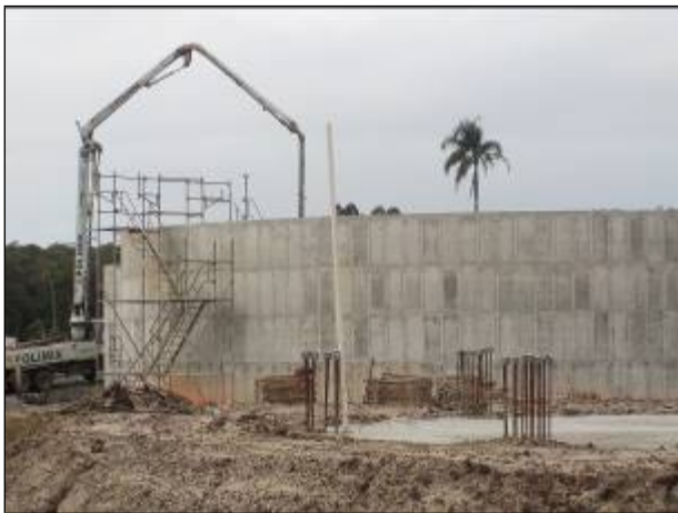
Figura 71: Vista de parte das obras da ETE Balneário Barra do Sul, em setembro de 2021.
