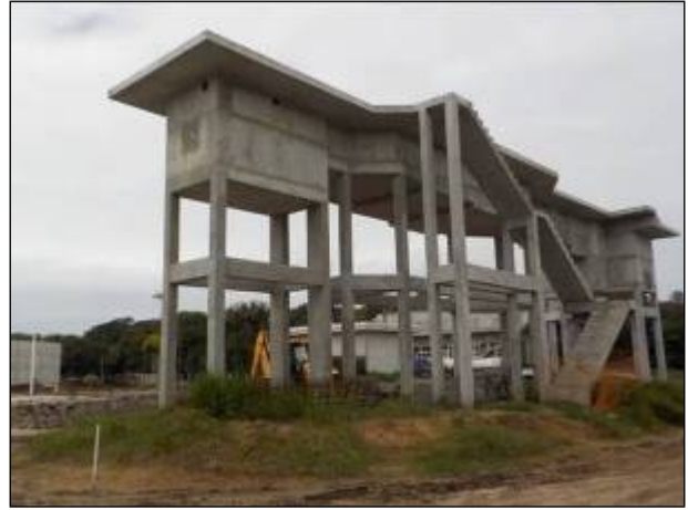
Figura 70: Vista de parte das obras da ETE Balneário Barra do Sul, em setembro de 2021.
