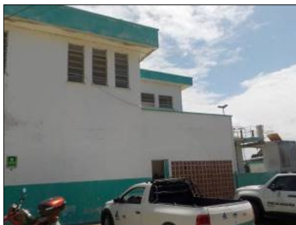
Figura 32: Vista da área interna da ETA Balneário Barra do Sul, localizada na rua Vicente de Carvalho.
