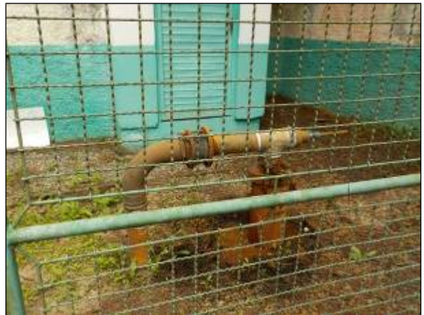
Figura 14: Vista em detalhe do Poço 2, local isolado com cercamento e cadeado.
