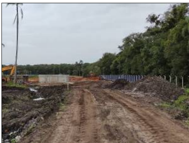
Figura 77: Vista de parte das obras da ETE Balneário Barra do Sul, em setembro de 2021.
