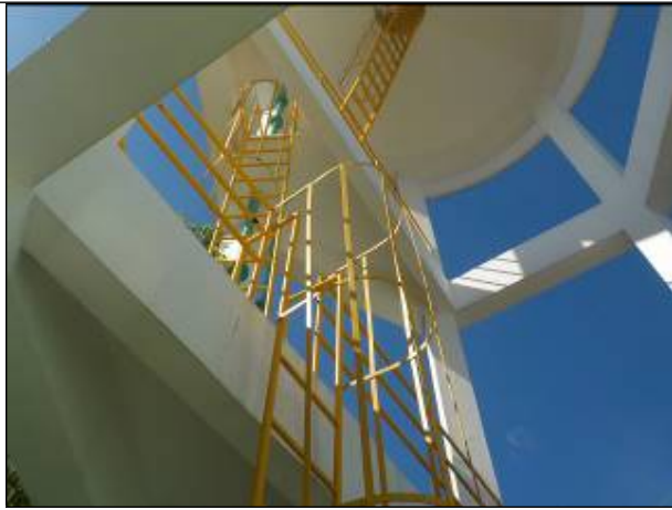
Figura 19: Vista da escadaria de acesso ao Reservatório.
