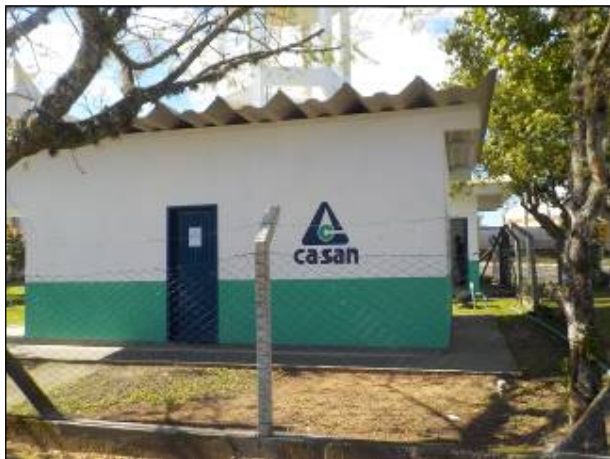
Figura 1: Fachada do Escritório de São João do Sul/SC.
