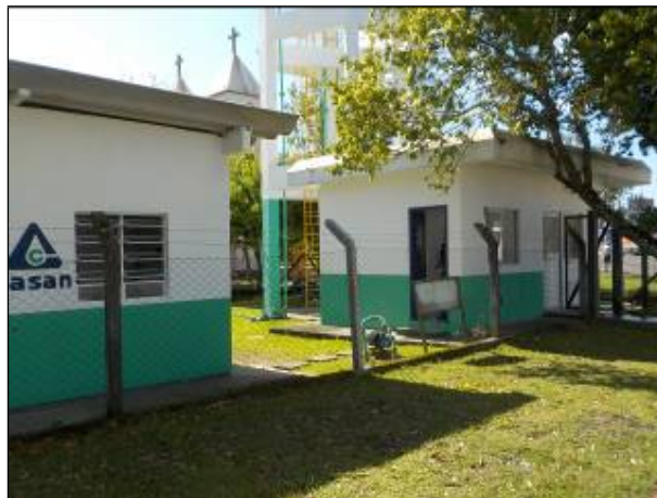
Figura 2: Novo Escritório de Atendimento de São João do Sul/SC (à direita), contendo acesso para cadeirantes.
