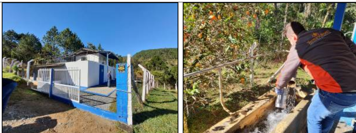
Figura 1 – Visão geral da ETA de Anitápolis e coleta de amostras de água bruta na entrada da ETA (28/07/2021).
