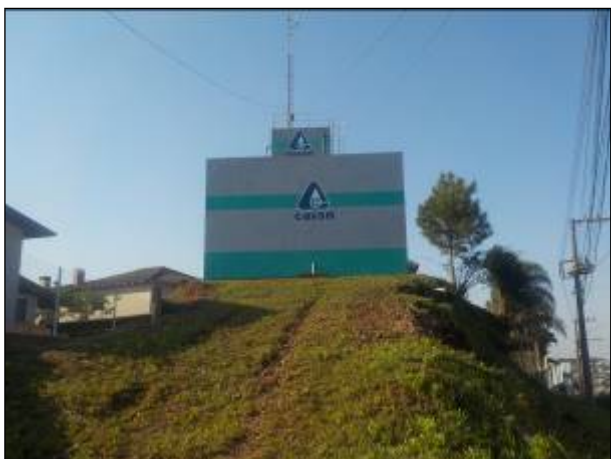
Figura 35: Vista parcial do Reservatório R3.
