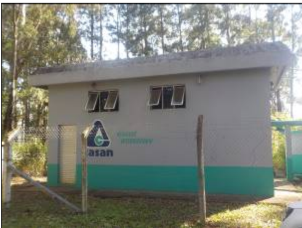
Figura 29: Estação de Recalque Água Tratada – ERAT Intermediária
