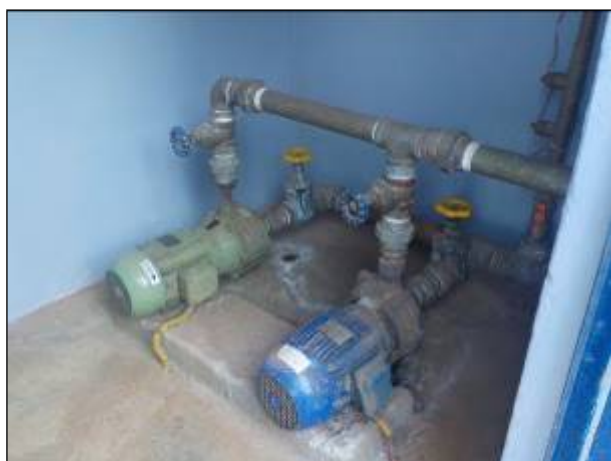
Figura 41: Bombas de recalque com 5CV, da Av. Brasil.
