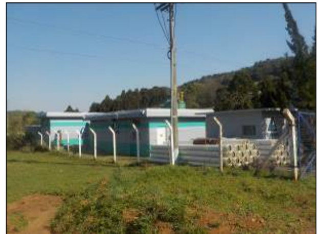
Figura 22: Vista parcial da ETA.
