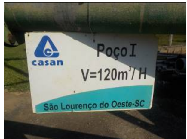
Figura 16: Identificação do poço 01.
