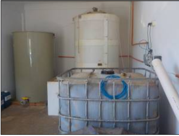
Figura 25: Local de armazenamento de produtos químicos.
