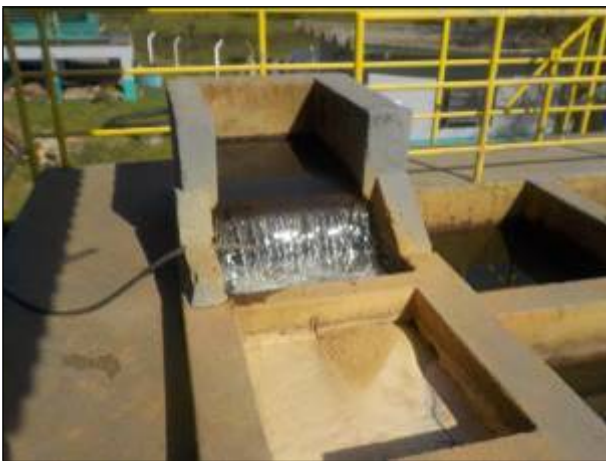
Figura 23: Entrada da Água Bruta na ETA.
