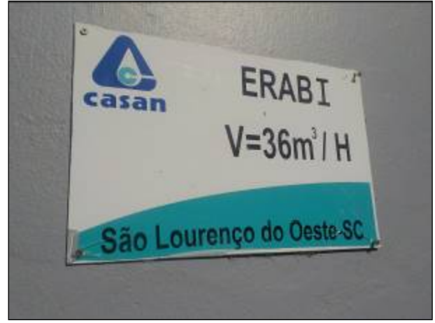
Figura 20: Estação de recalque de água bruta.
