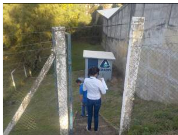
Figura 40: Acesso ao Recalque na Av. Brasil.
