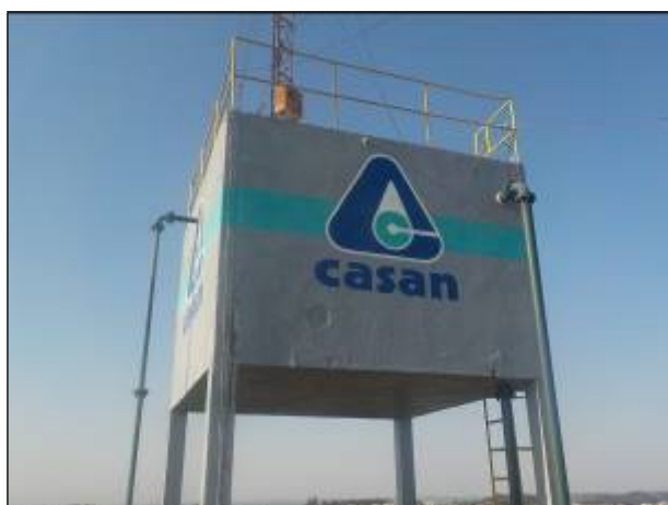
Figura 39: Vista do R3 de concreto elevado com capacidade de 20m 3 .
