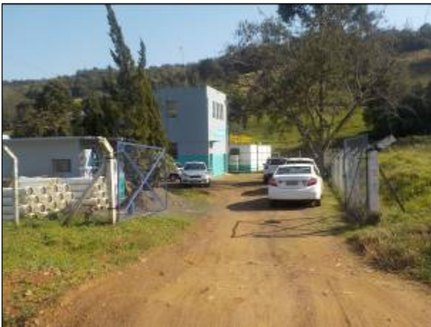
Figura 21: Entrada da ETA
