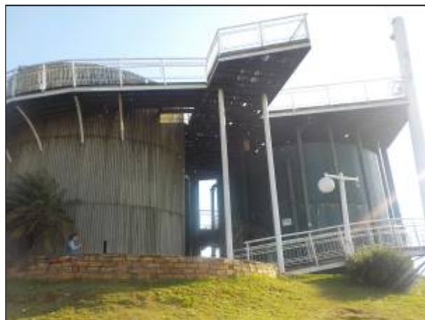
Figura 32: Reservatórios R1 e R2 – 2x400m 3 .
