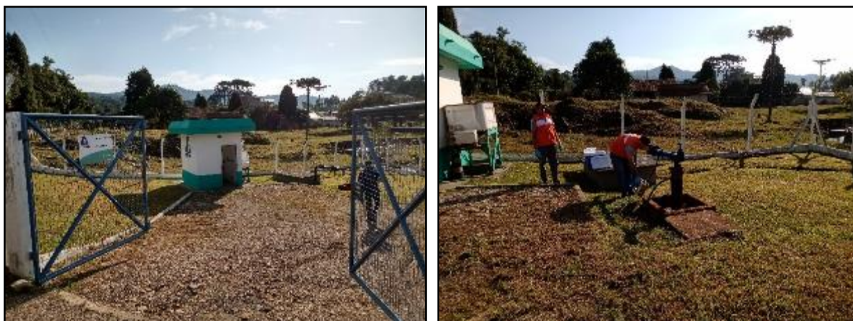
Figura 1: Visão geral do ponto de captação Poço 1 Taquaras e coleta de amostras de água bruta (26/05/2022).
