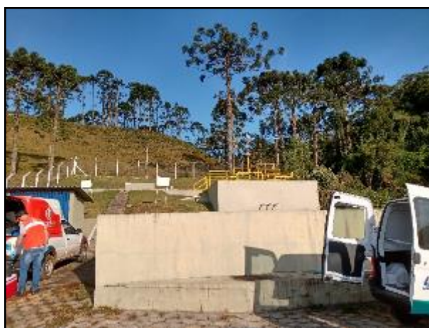
Figura 12: Visão geral da ETE de Rancho Queimado (26/05/2022).
