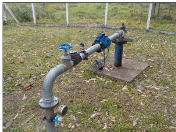
Figura 15: Vista aproximada do Poço Linha Fragnani, boas condições.
