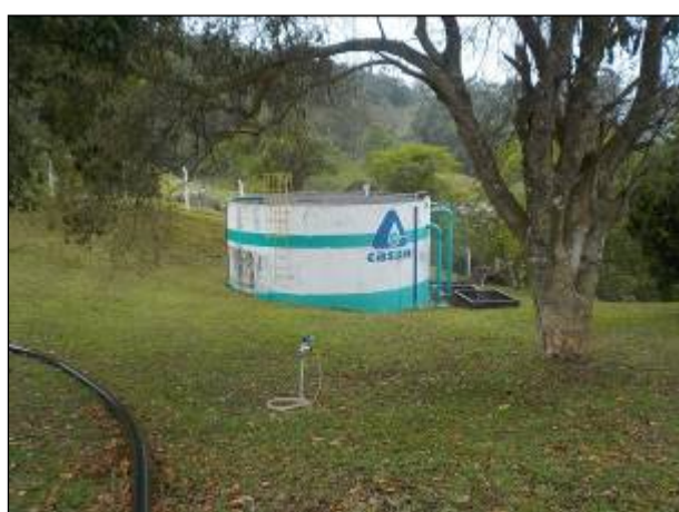
Figura 36: Vista do Reservatório R 01, localizado junto à ETA Treze de Maio, no mesmo terreno.
