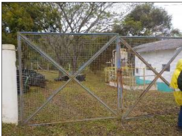
Figura 16: Vista da entrada da ETA Treze de Maio, portão de entrada em condições satisfatórias e protegida.
