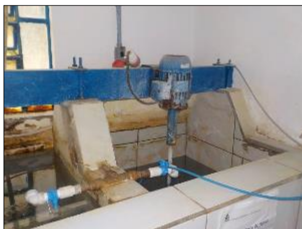
Figura 19: Vista dos equipamentos disponíveis na ETA Treze de Maio para a fluoretação, em funcionamento.
