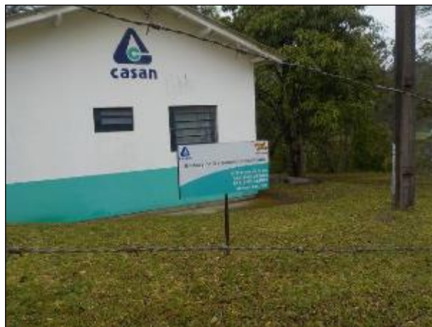
Figura 17: Placa indicativa da Unidade de Tratamento Simplificada (UTS), aqui denominada ETA Treze de Maio, adequada.
