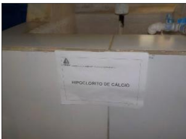
Figura 20: Vista da placa e local onde é misturado o hipoclorito de sódio, produto utilizado para desinfecção da água bruta.
