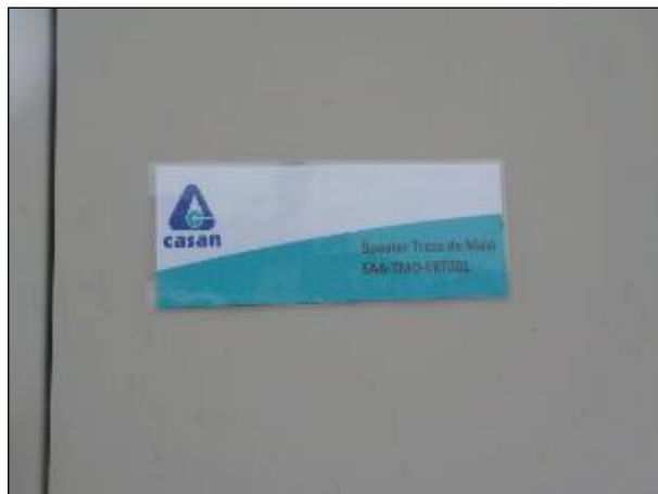
Figura 29: Detalhe da placa indicativa da unidade booster 01.
