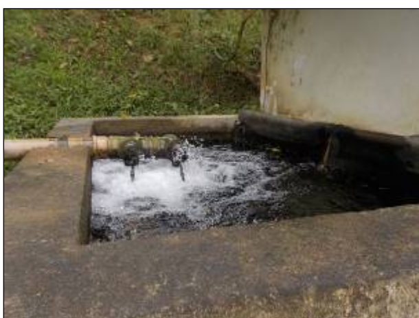
Figura 27: Local de chegada da água bruta proveniente da captação riacho São Marcos.
