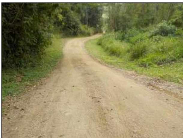
Figura 29: Via de acesso à ETA Rio Fortuna, esta que fica em local elevado distante cerca de 250 metros da rodovia SC-436.
