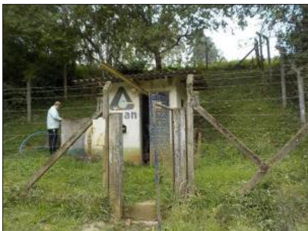
Figura 23: Vista geral da estrutura que comporta a ERAB 01, às margens da rodovia SC-436, portão e cercamento em condições satisfatórias.
