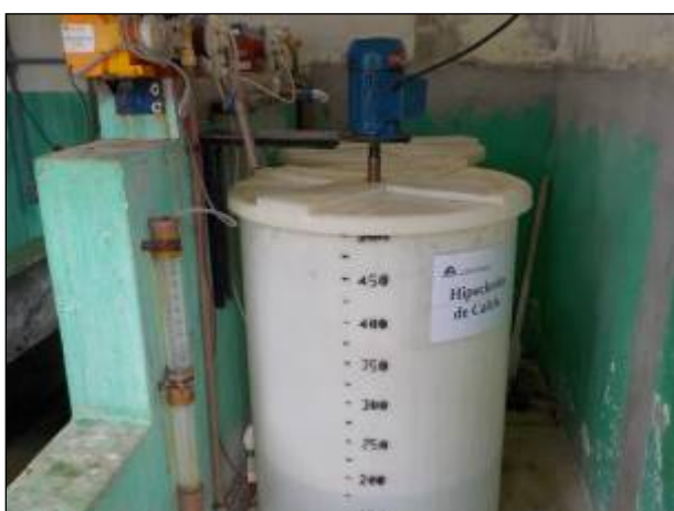
Figura 33: Recipientes para mistura dos produtos químicos no tratamento da água na unidade.
