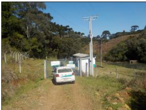
Figura 9: Acesso a Captação superficial Rio Antonina e ERAB 1.
