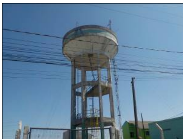
Figura 32: Vista Parcial do Reservatório R2 – Raia, elevado, no bairro N. Sra. Aparecida.
