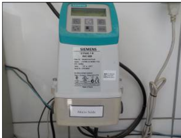
Figura 22: Detalhe do medidor da vazão de saída localizado na ETA.
