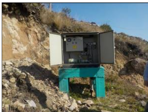
Figura 38: Vista da parte interna do Booster Vila Proença de São Joaquim, sem placa de identificação e unidade desprotegida.
