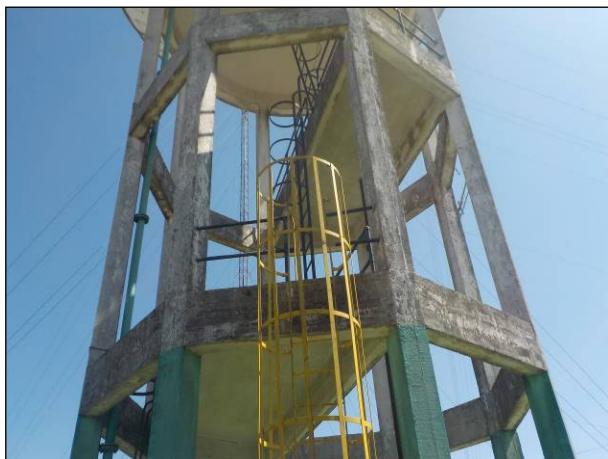
Figura 33: Vista parcial da escada de acesso aos operadores no Reservatório R2 – Raia, boas condições, incluindo guarda-corpo.
