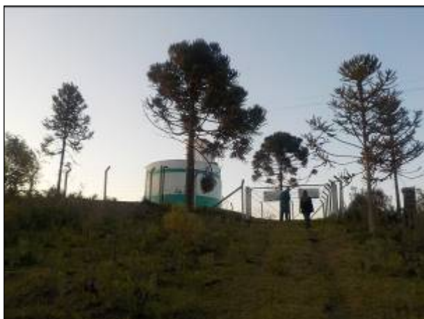
Figura 49: Vista do acesso ao Reservatório Santa Isabel, local protegido e identificado.
