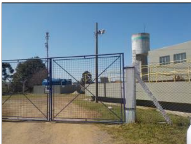
Figura 17: Vista do acesso à ETA convencional de São Joaquim, cercamento e portões adequados.
