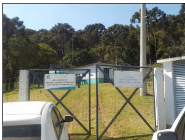
Figura 14: Vista da entrada de acesso a Estação de Recalque de Água Bruta – ERAB 2, portões e cercamento adequados, incluindo limpeza do local.
