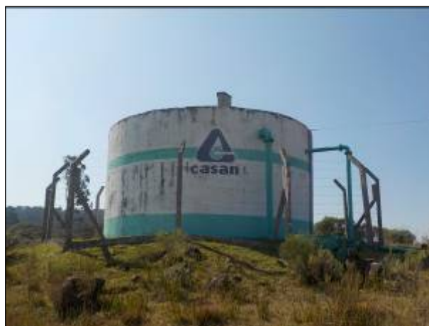
Figura 36: Vista parcial do Reservatório R1 (100m³), localizado no Parque da Maçã.
