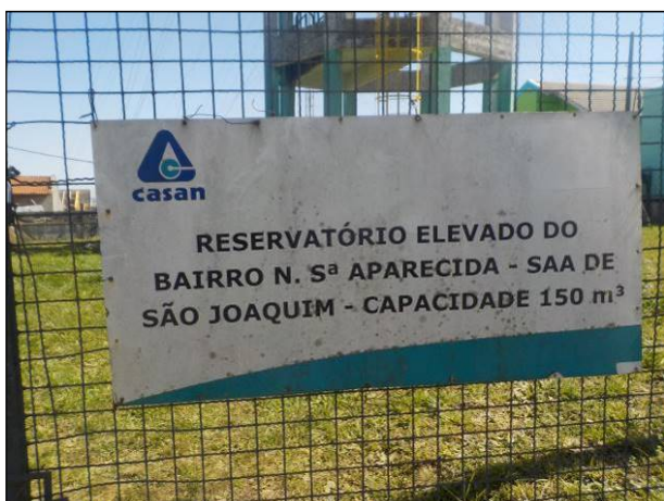
Figura 31: Placa indicativa do Reservatório R2 – Raia (150 m 3 ), também denominado Reservatório N. Sra. Aparecida.
