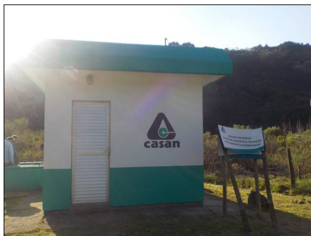
Figura 56: Edificação contendo o painel de controle da operação da unidade. Placa indicativa deslocada para conserto do poço adjacente.
