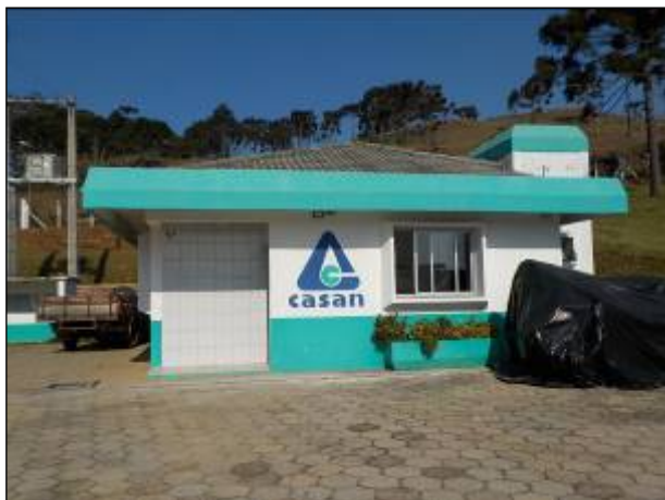
Figura 62: Vista da área externa e entrada da Casa de Química da ETE.
