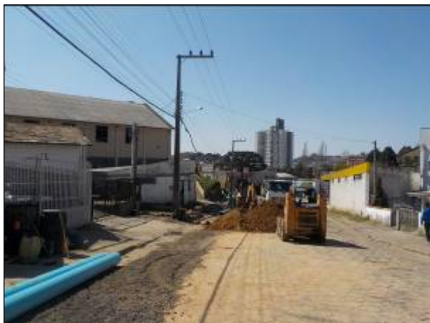
Figura 43: Vista de parte das obras de substituição das tubulações na rua Gregório Cruz com intuito de diminuição das perdas por pressão na rede.
