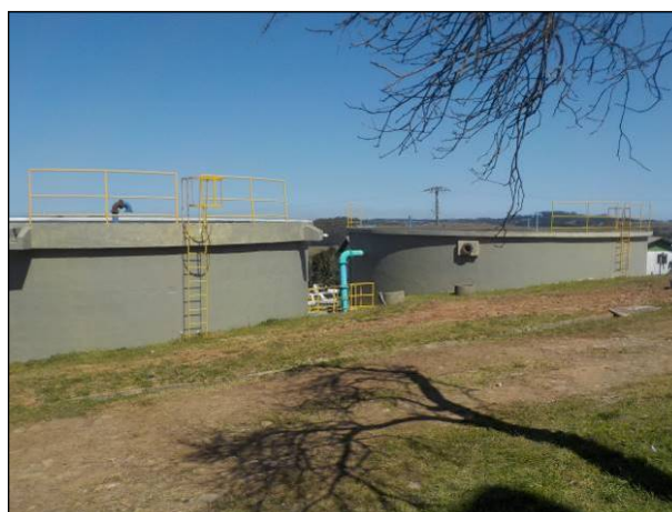
Figura 26: Vista dos Reservatórios R3 (450 m³) e R4 (500 m³), localizados no terreno da ETA.
