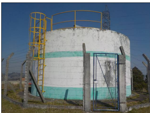
Figura 37: Vista do Reservatório R1, escada para os operadores e cercamento da unidade em boas condições.
