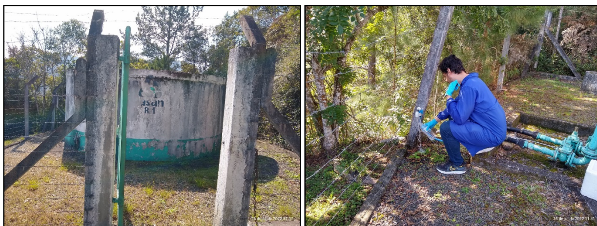
Figura 3: Visão geral do Reservatório R1 e coleta de amostras de água tratada (26/07/2022).
