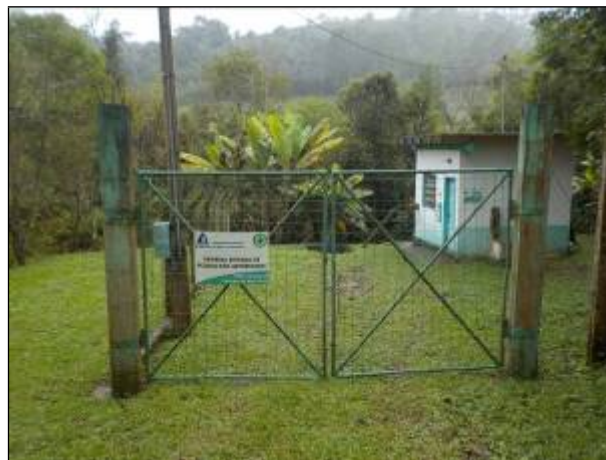
Figura 12: Vista do portão de entrada, placa informativa e estrutura do portão em boas condições, cadeado.
