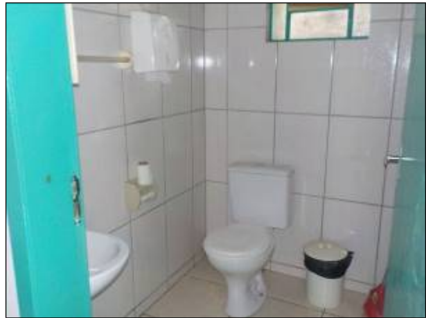
Figura 6: Vista interna do banheiro, boas condições.
