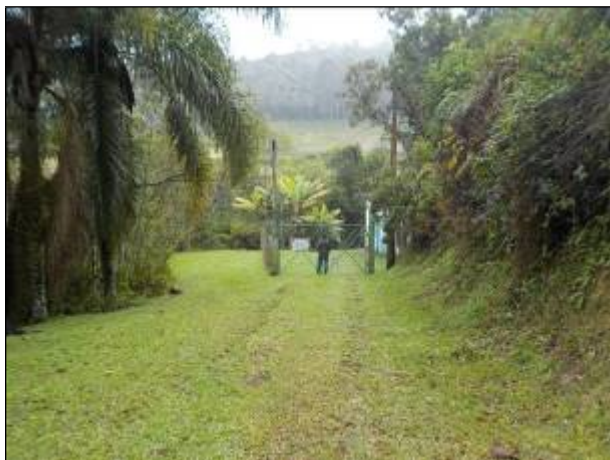
Figura 11: Entrada da Captação Rio Pisseta e ERAB 01, via em boas condições.
