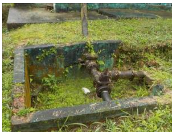
Figura 24: Estrutura da ERAB 01, boas condições.
