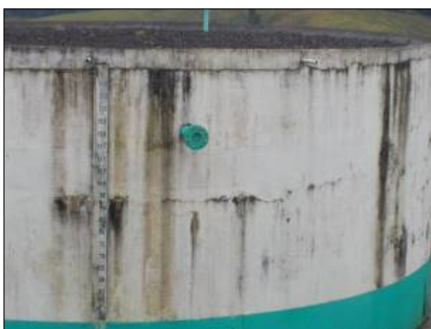
Figura 51: Vista em detalhe da estrutura do Reservatório R2, embora contenha telemetria, visualmente é difícil verificar o volume pela régua.
