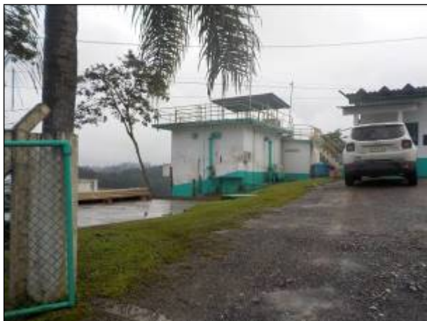
Figura 31: Vista da entrada da ETA Rio do Oeste, área de tratamento ao centro, Escritório à direita.
