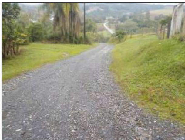
Figura 29: Vista da via de entrada para a ETA Rio do Oeste, boas condições.
