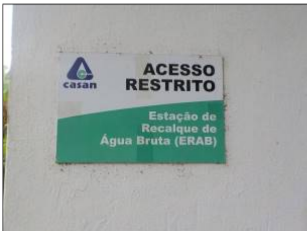
Figura 17: Vista da placa indicativa da ERAB 01 afixada na unidade.
