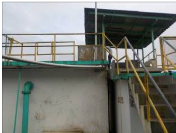
Figura 32: Vista da escada de acesso à área de tratamento na ETA Rio do Oeste, condições satisfatórias.
