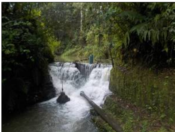
Figura 15: Vista da estrutura de captação no Rio Pisseta.
