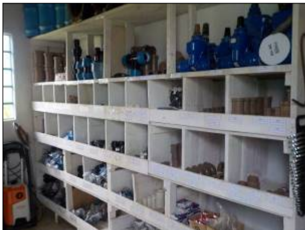
Figura 7: Almoarifado dos componentes para manutenção do SAA, junto ao Escritório e ETA.
