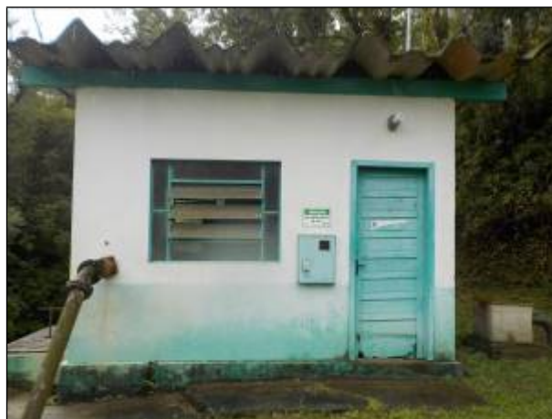
Figura 18: Vista da estrutura externa da unidade ERAB 01.
