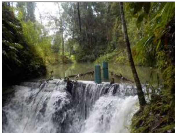
Figura 14: Vista da Captação no Rio Pisseta.
