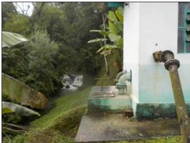
Figura 13: Vista da Captação, ao fundo, e da estrutura da ERAB 01, à direita.
