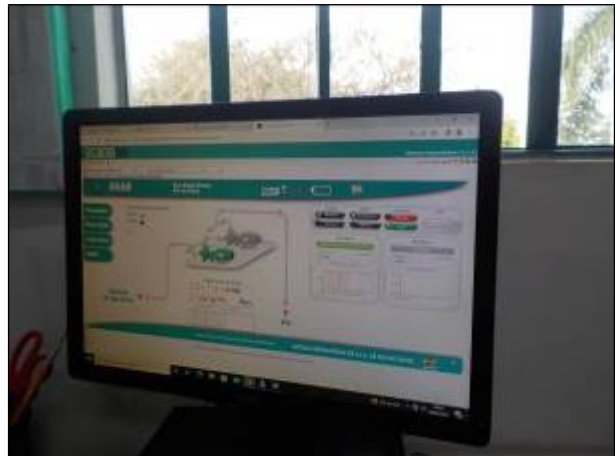
Figura 10: Sistema denominado Scada, implantado para monitoramento do SAA de Rio do Oeste pela Concessionária.
