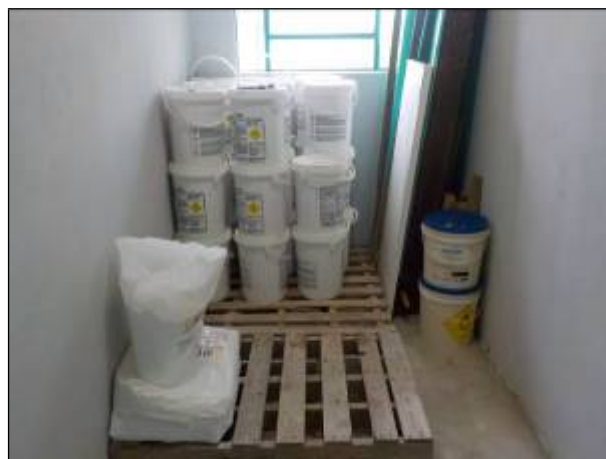
Figura 42: Armazenamento dos produtos químicos em local junto ao Escritório e ETA, estes dispostos adequadamente sobre paletes.
