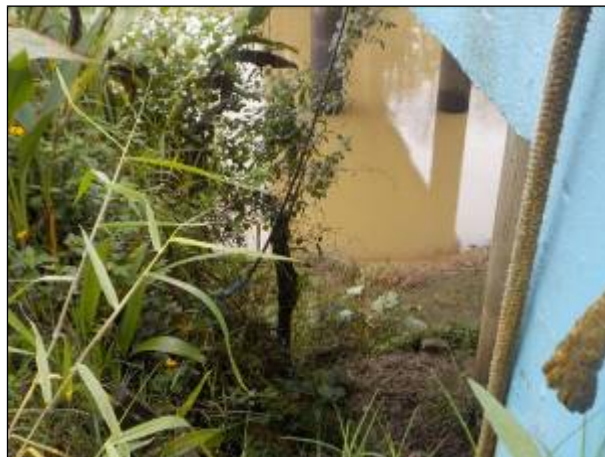
Figura 26: Local de Captação no Rio Itajaí do Oeste, próximo à ponte, distante cerca de 300 metros da ETA.
