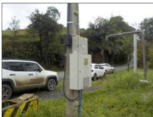
Figura 28: Vista da estrutura da ERAB 02, junto ao poste de energia; ao fundo e à direita está o acesso à ETA Rio do Oeste.
