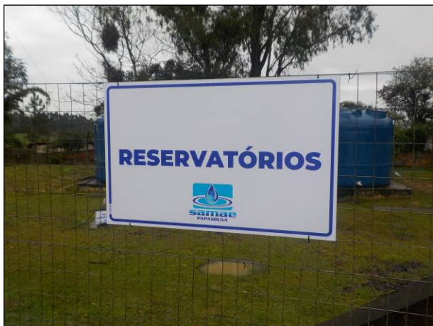
Figura 83: Vista da placa indicativa do local onde estão os reservatórios, tanto o principal quanto os auxiliares, boa condição.
