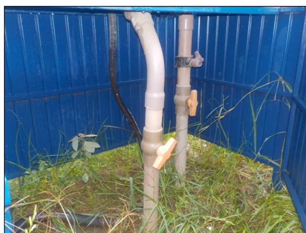
Figura 78: Vista da estrutura do booster 08, condições satisfatórias.
