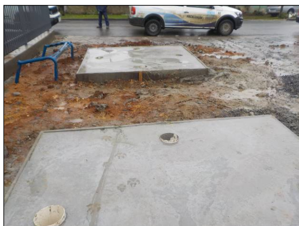
Figura 92: Vista em detalhe das obras na COHAB I, ao lado do Posto de Saúde da comunidade, previsão de conclusão e instalação dos equipamentos para o início do ano de 2023.
