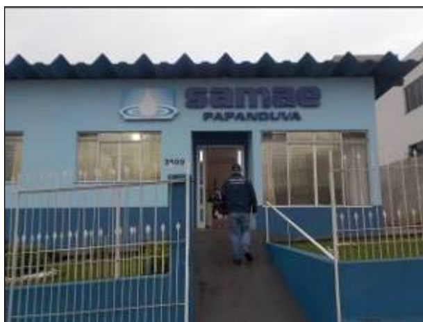
Figura 1: Vista parcial da entrada do escritório de Atendimento. Acesso a pessoas com mobilidade reduzida adequado.
