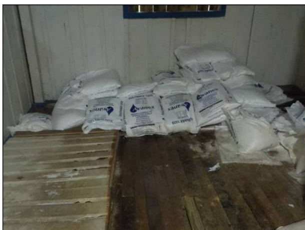
Figura 41: Produtos químicos a serem utilizados no tratamento na ETA Papanduva armazenados de forma inadequada, sem paletes e em local úmido.
