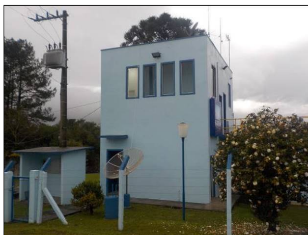
Figura 26: Edificação na ETA e parte do cercamento e portão de entrada, estrutura em boas condições de conservação, pintura e limpeza.
