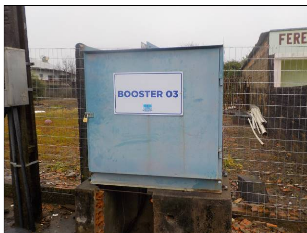
Figura 60: Vista do booster 03, placa indicativa da unidade satisfatória, porém estrutura em condições insatisfatórias na rua Ladislau Tabalipa, incluindo limpeza do entorno.
