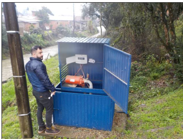
Figura 67: Vista interna da unidade, boas condições.
