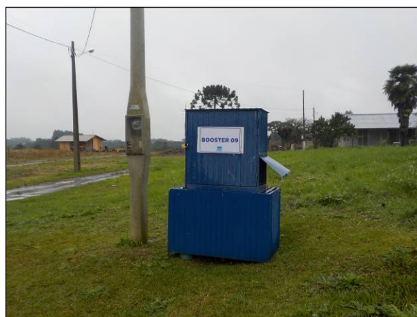
Figura 80: Vista geral do booster 09, boas condições no entorno, placa indicativa, pintura e cadeado adequados.
