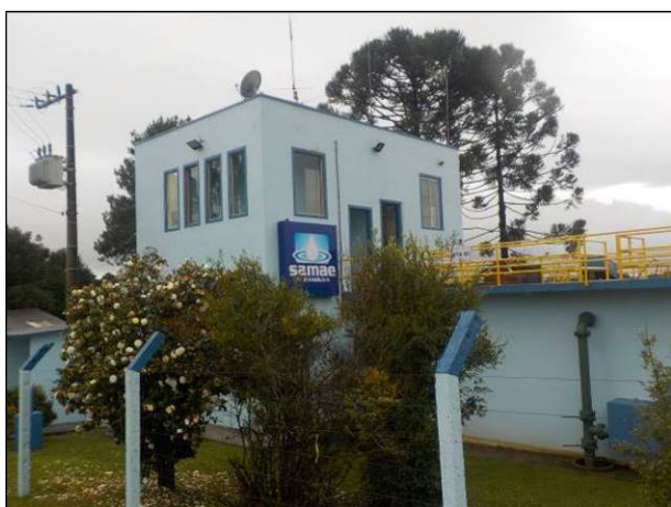
Figura 25: Vista da edificação onde ficam os operadores da ETA Papanduva e parte da área de tratamento (à direita).
