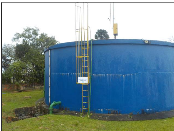
Figura 85: Vista de parte da estrutura do Reservatório Principal (300 m 3 ).
