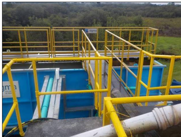
Figura 34: Vista do acesso entre as ETAs e das tubulações que as conectam, condições satisfatórias.
