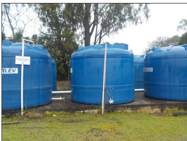
Figura 89: Vista dos Reservatórios Auxiliares, condições satisfatórias da estrutura.
