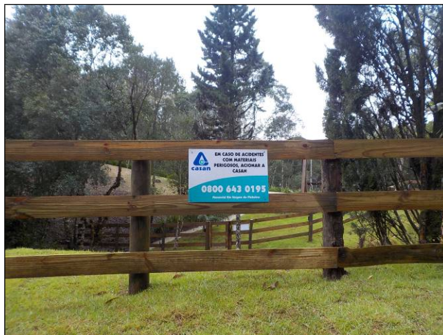
Figura 14: Placa indicativa da captação superficial, afixada corretamente na cerca de proteção do local
