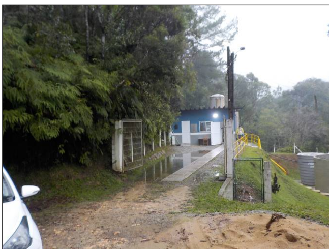
Figura 23: Vista da entrada e acesso à ETA Angelina, boa condição do terreno e dos equipamentos disponíveis, incluindo a edificação.
