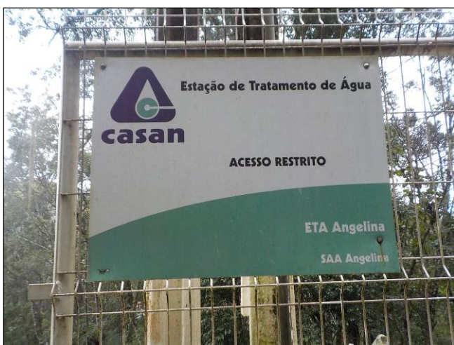
Figura 21: Placa indicativa e restritiva afixada no portão de acesso à unidade ETA Angelina.
