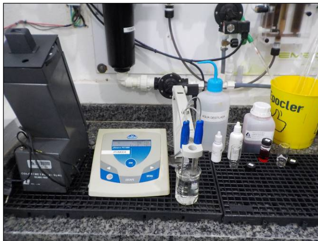
Figura 32: Vista em detalhe dos equipamentos para análise dos parâmetros na unidade. Boa condição e contendo armários para guarda daqueles que não estão em uso.
