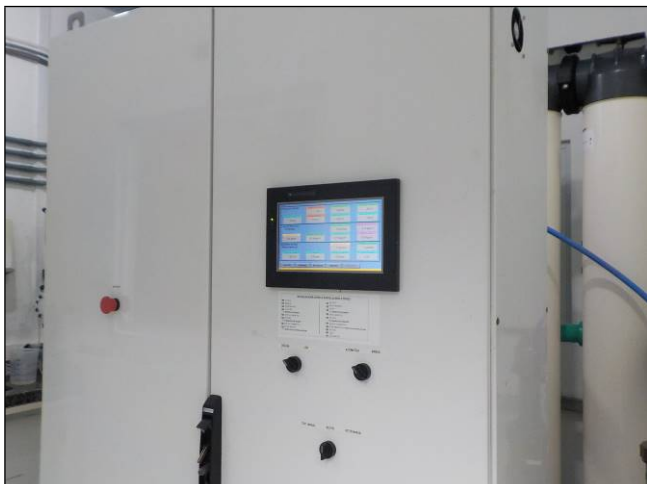
Figura 25: Vista do equipamento de controle da operação da ETA por Ultrafiltração.
