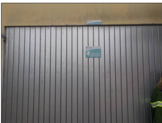
Figura 9: Porta de acesso ao almoxarifado, aos fundos do escritório de atendimento. Placas informativas e restritivas afixadas.
