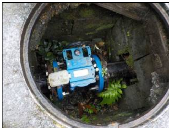
Figura 42: Medidor de vazão de saída da reservação, este também pode ser visualizado no monitoramento remoto da unidade.
