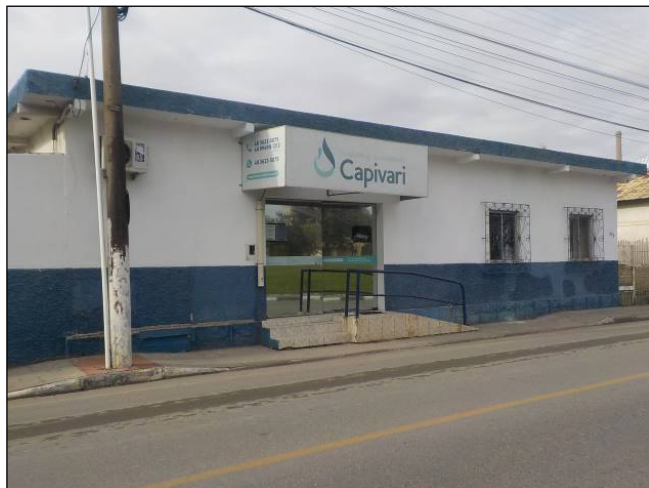
Figura 1: Escritório de Atendimento em Capivari de Baixo, acessibilidade satisfatória.
