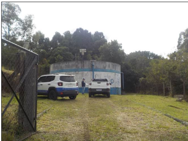
Figura 35: Reservatório R3 (500 m 3 ) visto a partir de sua entrada principal, localizado em local de acesso por propriedades particulares. Área adjacente reservada para implantação futura de novo reservatório de igual volume.
