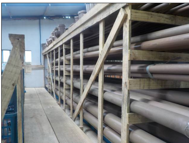
Figura 9: Vista de parte do almoxarifado, contendo tubulações, organizado adequadamente.
